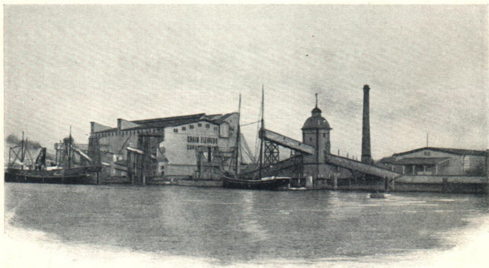
Элеваторъ на лѣвомъ берегу Морского канала.
