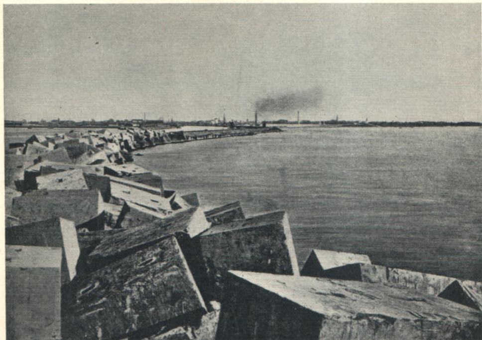
Южный молъ (часть мола, построенная изъ наброски массивовъ).
