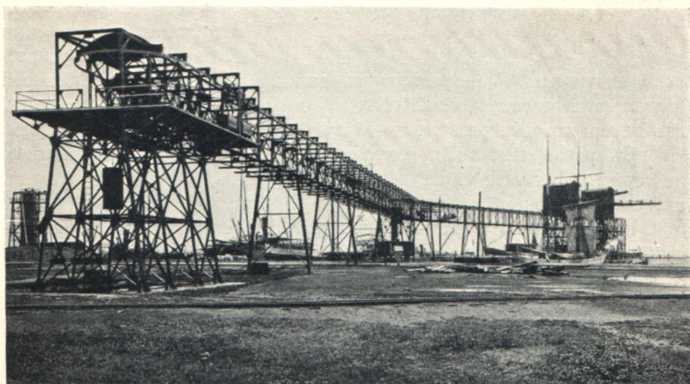
Элеваторъ и эстакада системы Гунта для выгрузки изъ судовъ руды.
