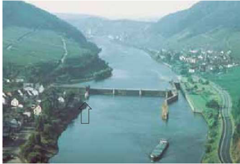
Рис. 1. Розмір рибопропускної споруди (показаний стрілкою) у порівнянні з розміром дамби
