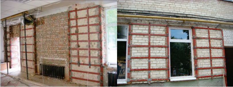
Рис. 5.14. Підсилення простінків зовнішньої несучої стіни будівлі сталевими обоймами
