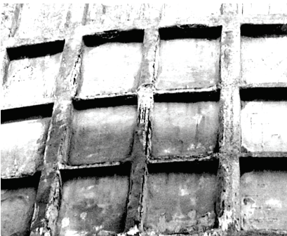
Рис. 2.39. Руйнування горизонтальних і вертикальних ребер збірних плит градирні
