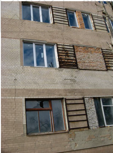
Рис. 2.10. Вертикальні тріщини у простінках зовнішньої несучої стіни поліклініки ЦРЛ м. Ізяслав Хмельницької області
