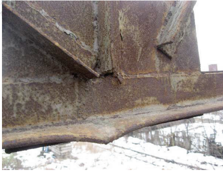
Рис. 2.22. Деформація полички кутика нижнього поясу ферми
