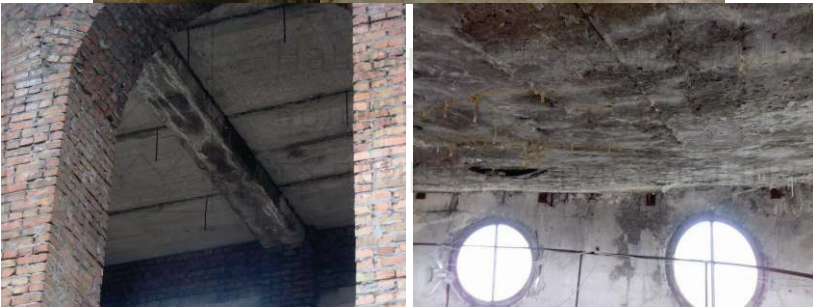
Рис. 2.4. Корозія бетону конструкцій будівель та інженерних споруд
