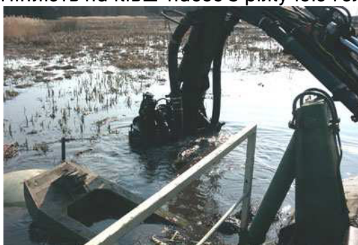
Рис. 8. Роботи з днопоглиблення з допомогою ківша-насоса
