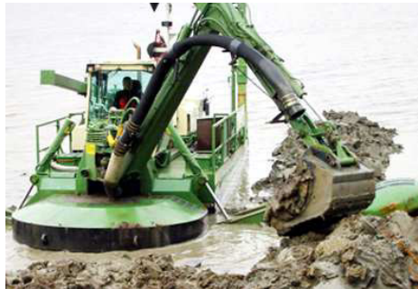
Рис. 11. Днопоглиблювальні роботи з використанням «зворотної лопати»
