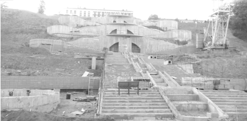
Рис. 4. Общий вид склона после устройства основных бетонных работ
