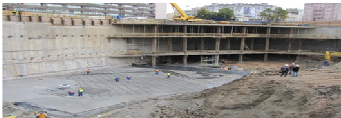
Fot.3. Wykop zabezpieczony ścianami szczelinowymi [12]
