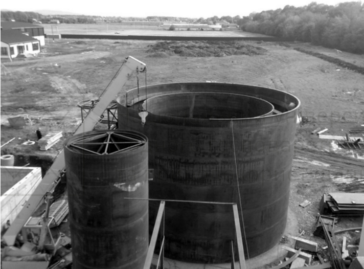
Рис. 3. Монтаж очисних споруд забійного цеху ТОВ «Драчинецьке-1»
