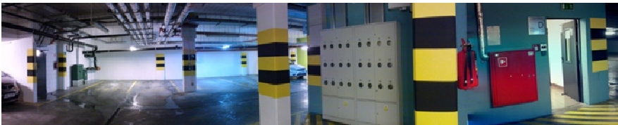
Fotografia 1. Garaż podziemny w budynku wielorodzinnym - Warszawa - Targówek (fot. Julia Moczydłowska)
