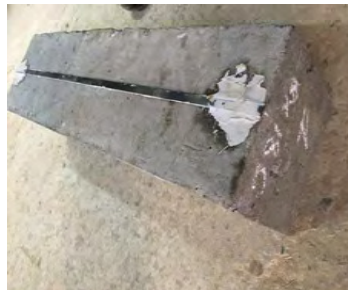
Рис. 3. Приклеювання композитної арматури
