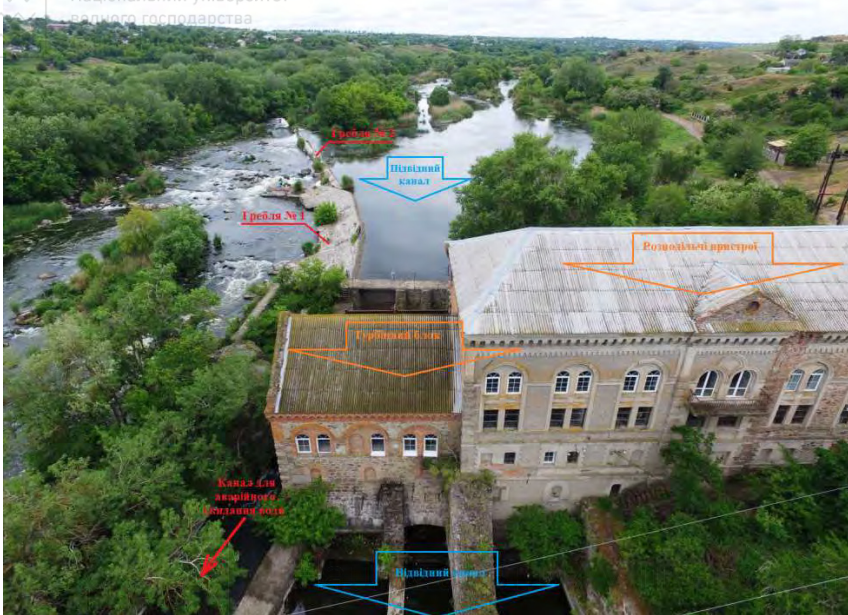
Рис. 1. Загальний вигляд гідровузла Мигійської ГЕС
