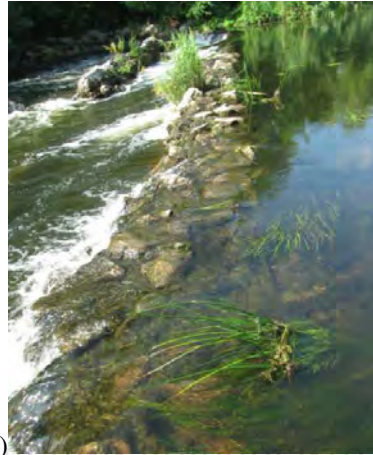
Рис. 4. Промоїни гребеню греблі № 2
