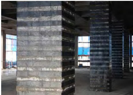
Рис 2. Схема підсилення колон вуглеволокном
