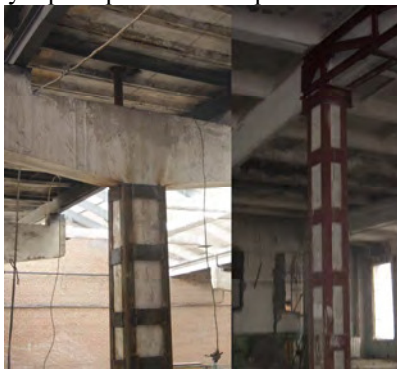
Рис 1. Схема підсилення колон сталевими кутиками
