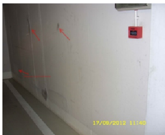
Fotografia. 5 a, b. Zawilgocenia na ścianach zewnętrznych garażu.
