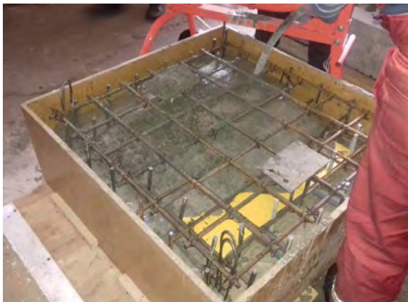
Рис. 1 – Опалубка з вкладеним каркасом, підготовлена для бетонування плит П1 та П2
