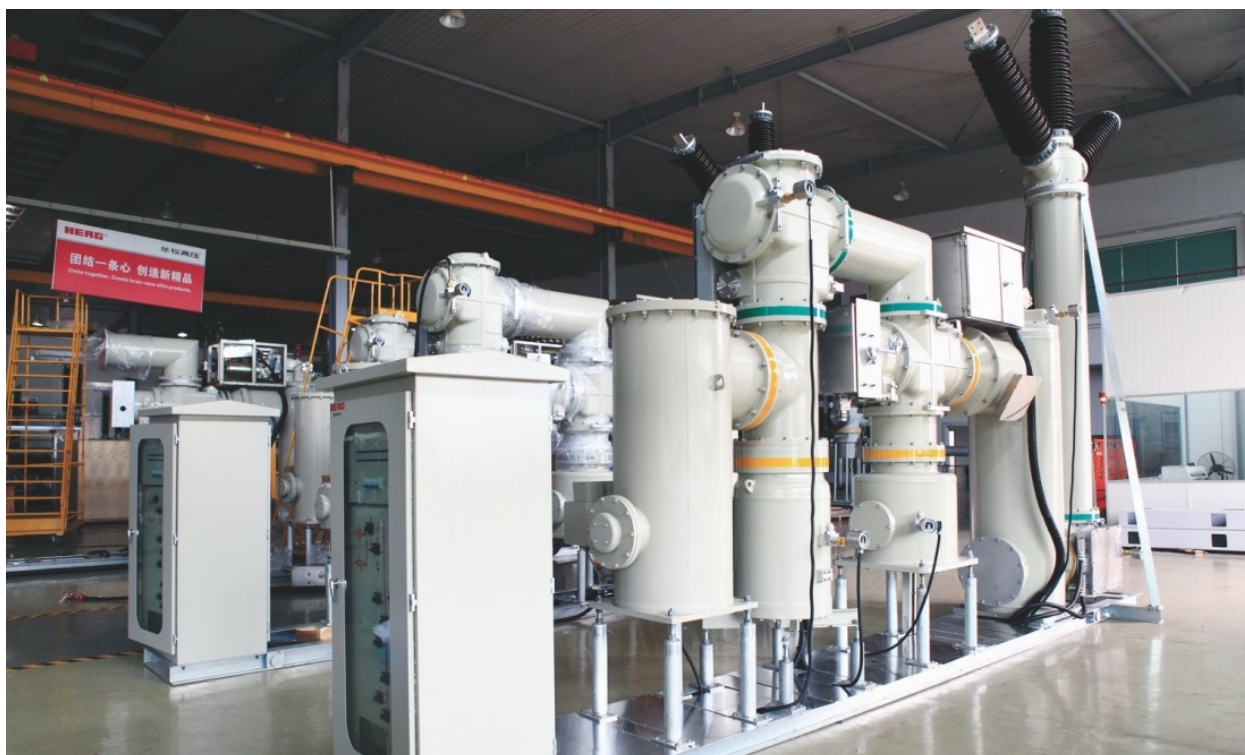
Рис. 3.7. Комплексний елегазовий розподільчий пристрій 110 кВ серії ZFW-126, являє собою єдиний технологічний комплекс із стандартизованих функціональних модулів: вимикач, шини, роз'єднувач, заземлюючий роз'єднувач, лінійний роз'єднувач, заземлюючий роз'єднувач, швидкодіючий заземлюючий роз'єднувач, трансформатори струму, трансформатори напруги, обмежувачі перенапруг, повітряне/кабельне введення тощо, а також системи управління і контролю
