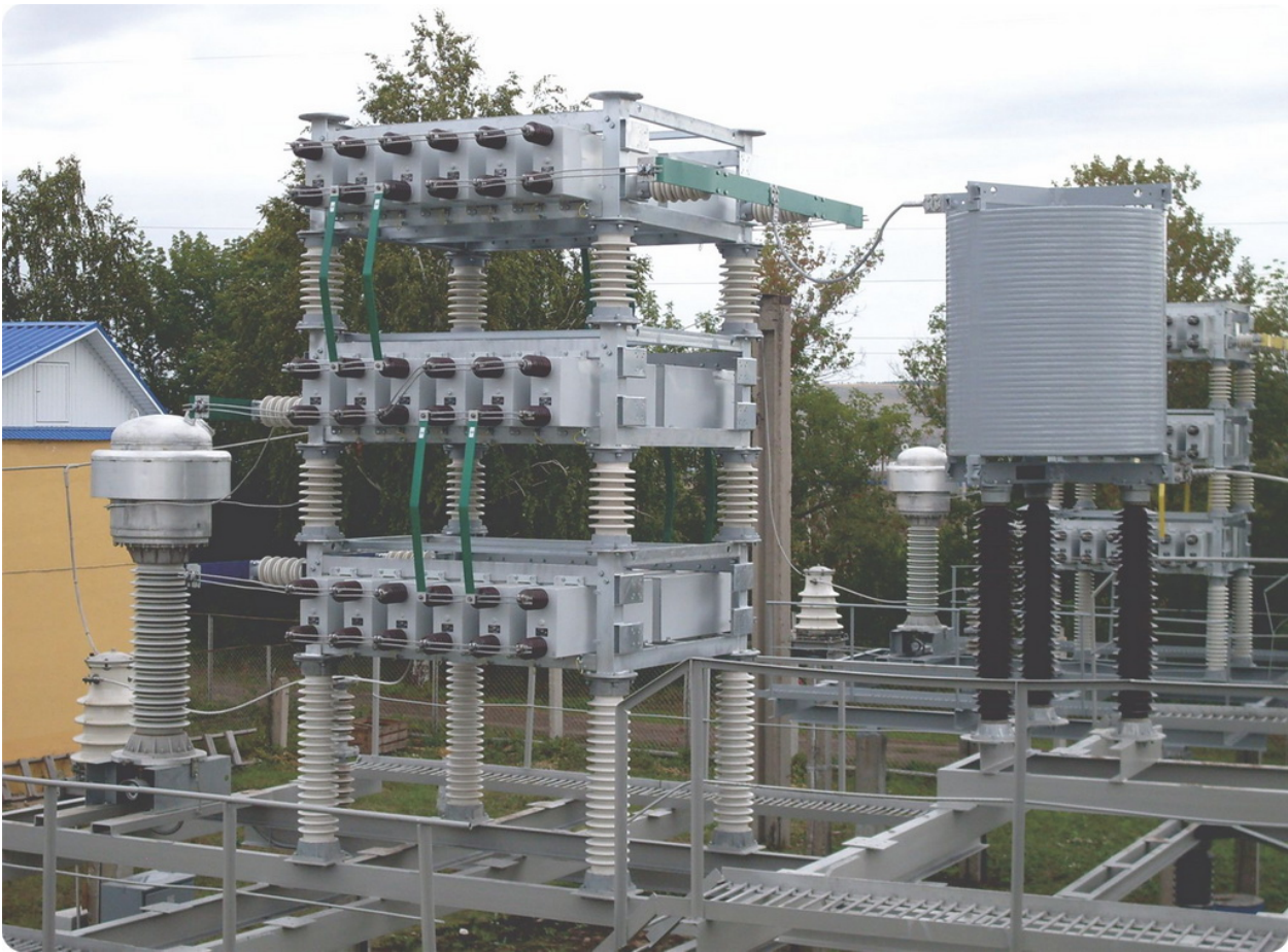
Рис. 3.12. Батарея статичний конденсаторів для підвищення коефіцієнта потужності мережі
