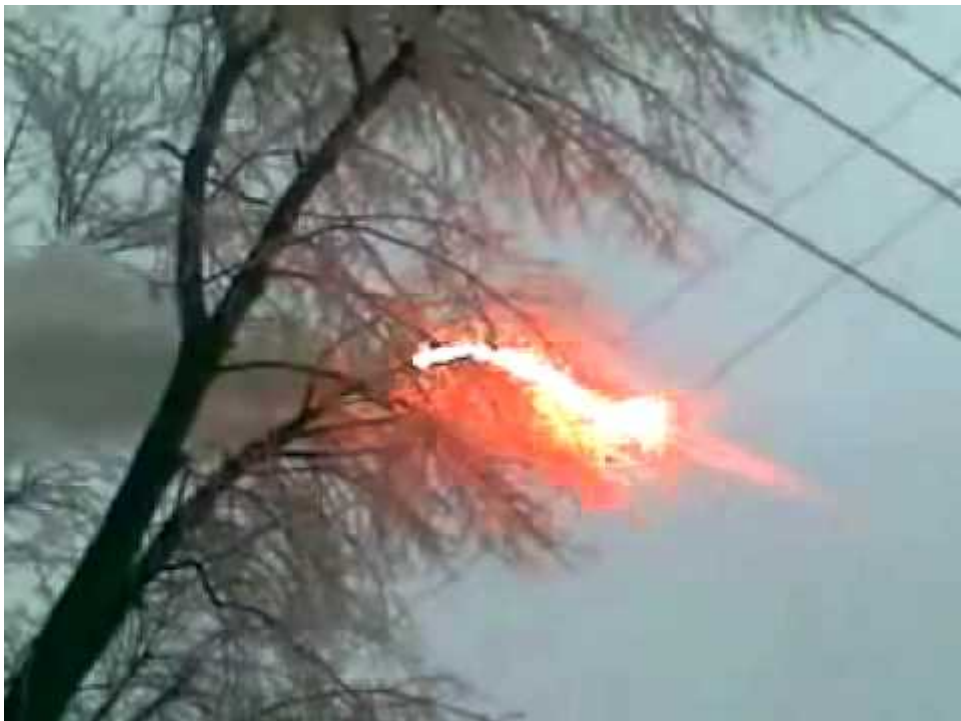
Рис. 1.12. Однофазне замикання в мережі 110 кВ (через дерево)
