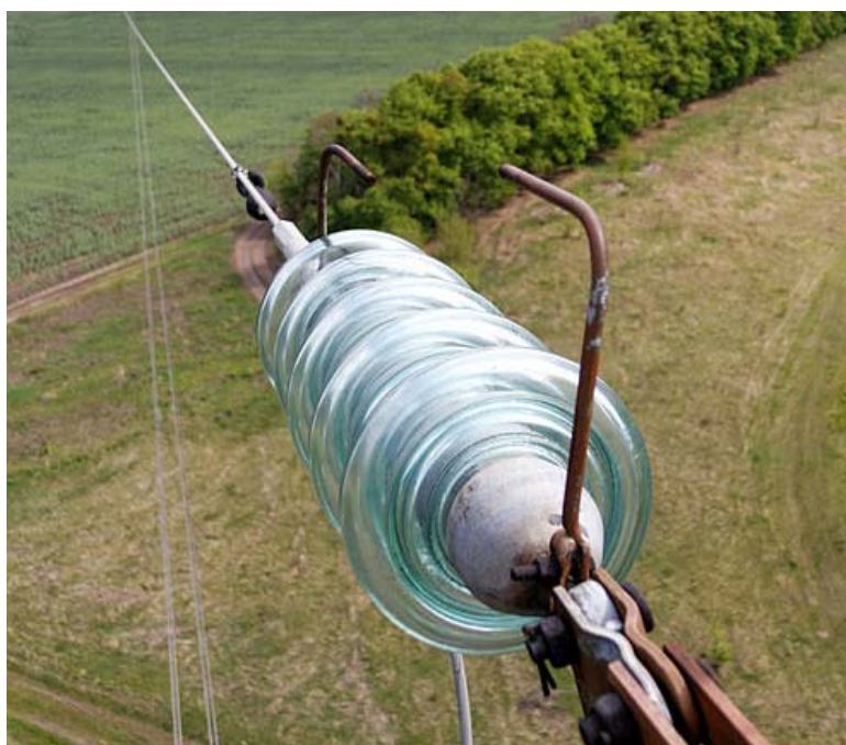
Рис. 2.9. Кріплення грозотросу з іскровим розрядником
