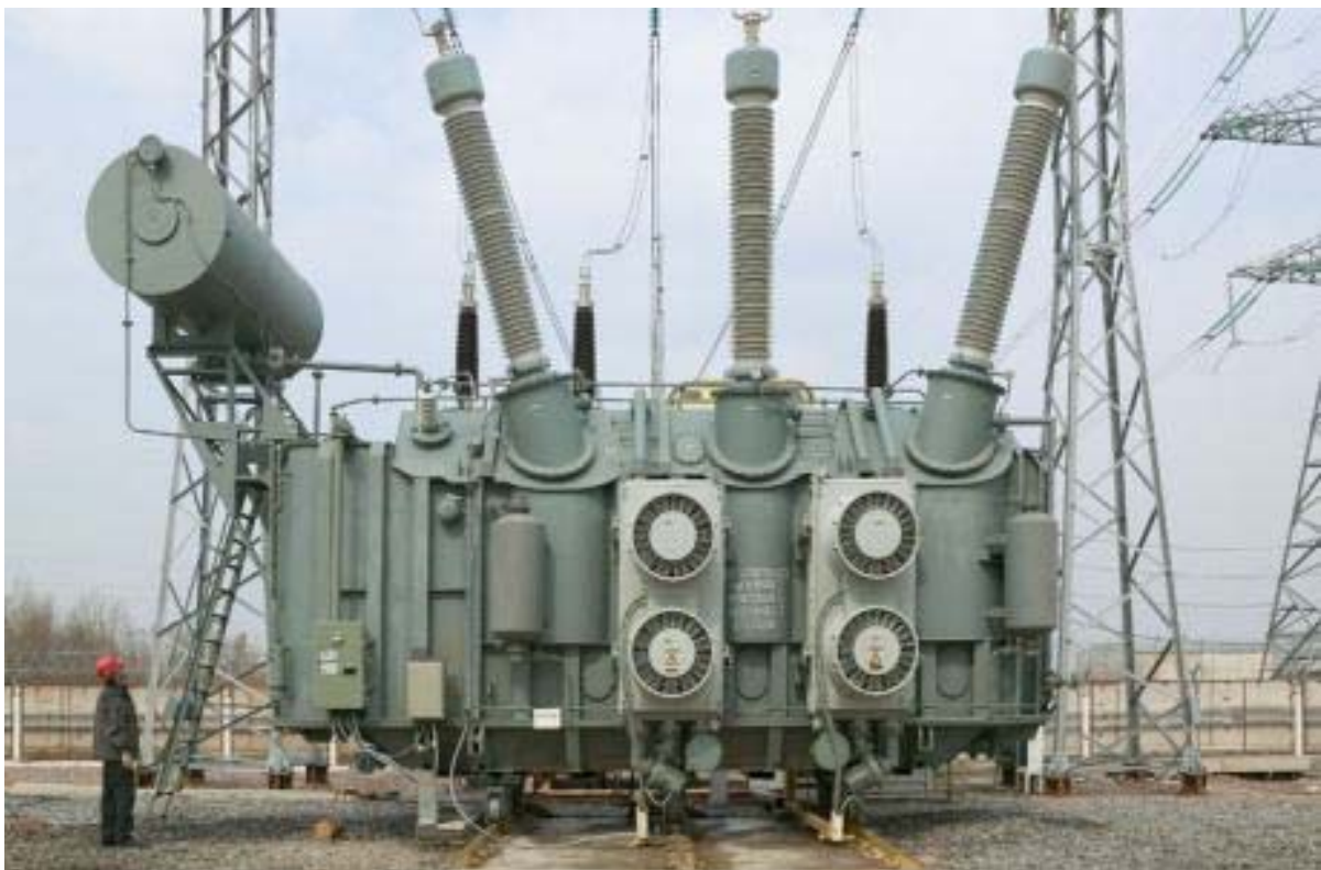
Рис. 1.4. Високовольтний силовий трансформатор
