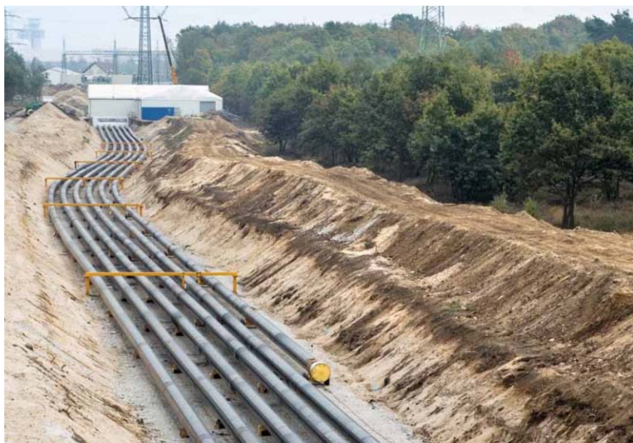
Рис. 3.18. Лінії електропередачі з газовою ізоляцією
