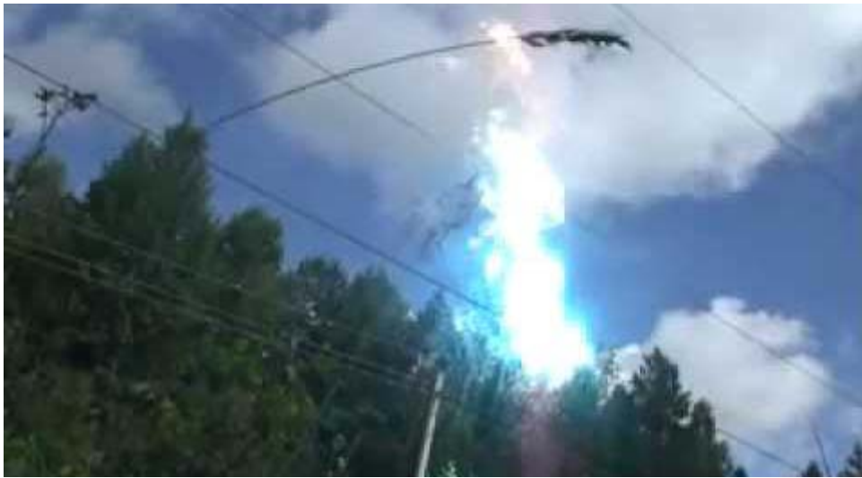
Рис. 1.11. Замикання на ЛЕП 110 кВ
