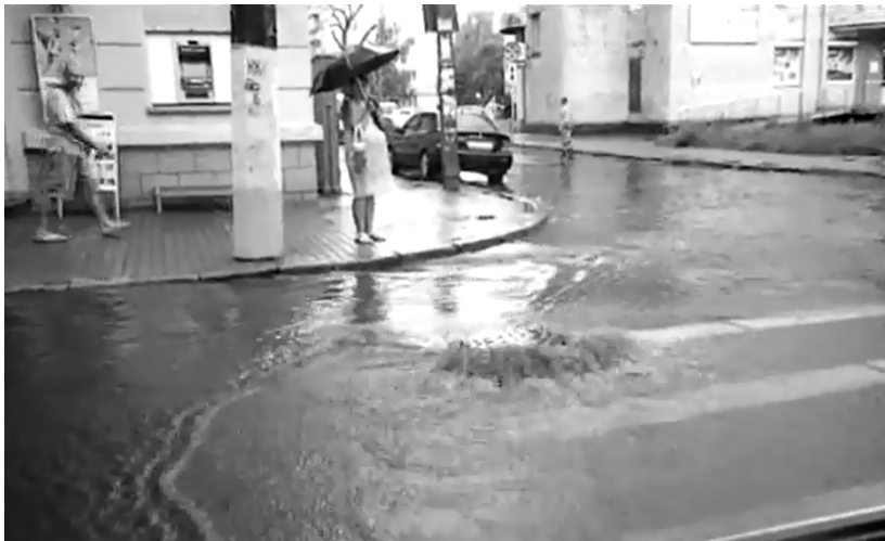
Рис. 3. Затоплення міської вулиці через люк колодезя дощової мережі (м. Житомир, 12.09.2013 р.)
