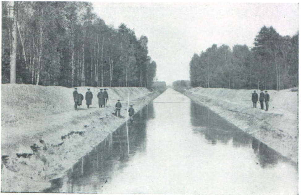
Ветельскій магистральный сплавной каналъ на земляхъ им. Закозелье Гр. Бобринской; уширенъ и углубленъ въ 1912 г., въ цѣляхъ осушенія казен. Ветельской дачи, Леликовскаго лѣсничества.
