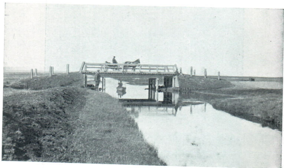
Фиг. 11. Заболотскій магистр. каналъ, близъ с. Заболотья, Ковельскаго уѣзда. Уширень и углублень въ 1910—11 г.г.
