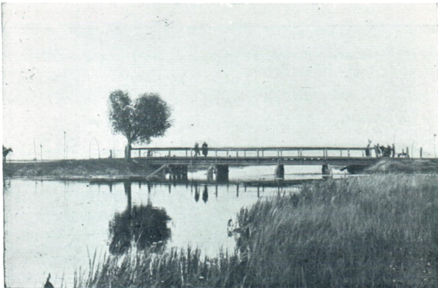
Болота с. Горникъ, при пересѣченіи шоссе Ковель-Брестъ съ Турскимъ водопроводомъ.
