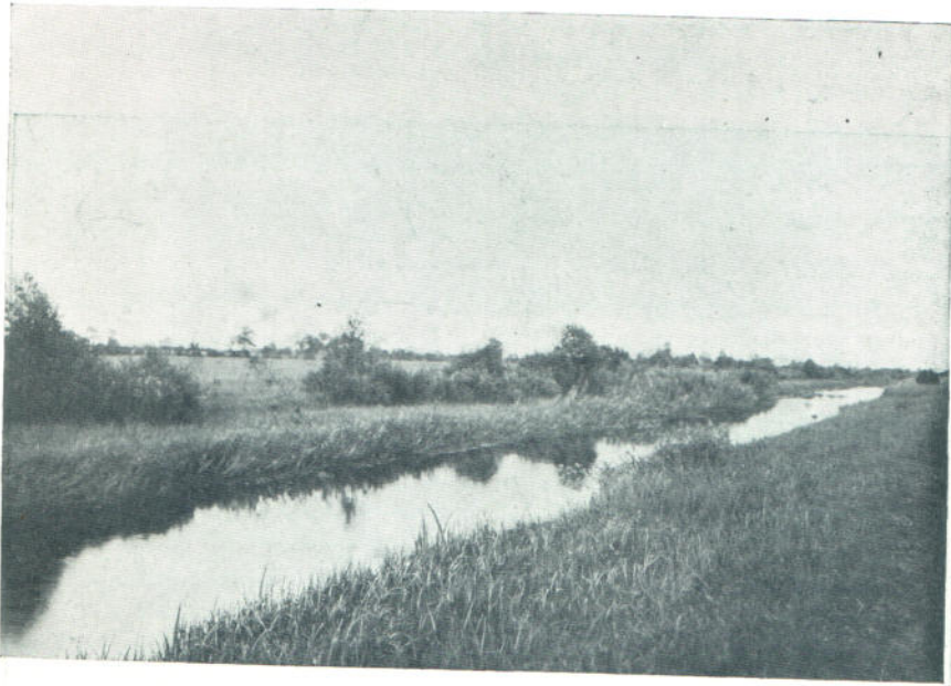
Орѣховскій водопроводъ, у с. Повитья.
