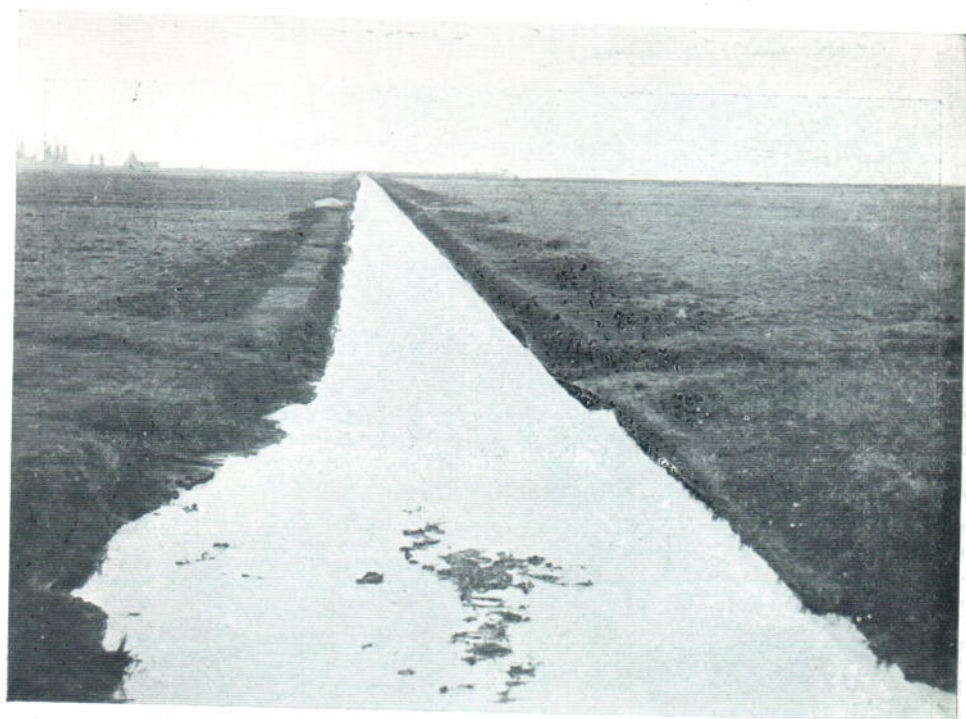
Фиг. 12. Заболотскій магистральный осушительный каналъ, на земляхъ крестьянъ с. Заболотья, Ковельскаго уѣзда. Уширень и углублень въ 1910—1911 г.г.
