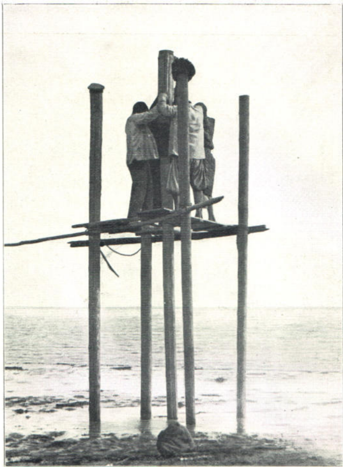
№ 17. Забивка свай. Начало забивки (свая въ землѣ на 1 арш.).
