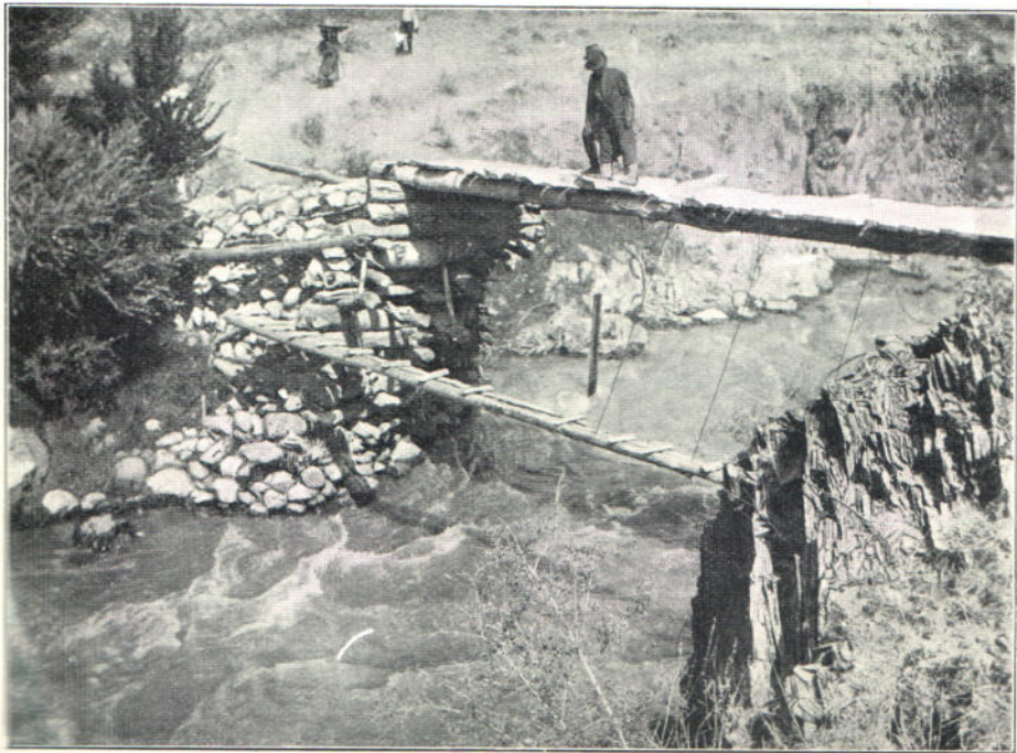
№ 10. Р. Араванъ-сай. Постъ Наукатскій. Водомѣрная рейка на рельсовой сваѣ и гидрометрической мостикъ. Видъ вверхъ по теченію.
