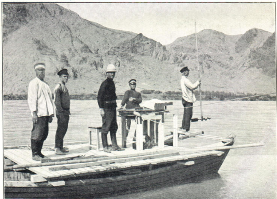
№ 31. Р. Или. Ст. Илійская. Работа вертушкой Амслера на створъ станции.
