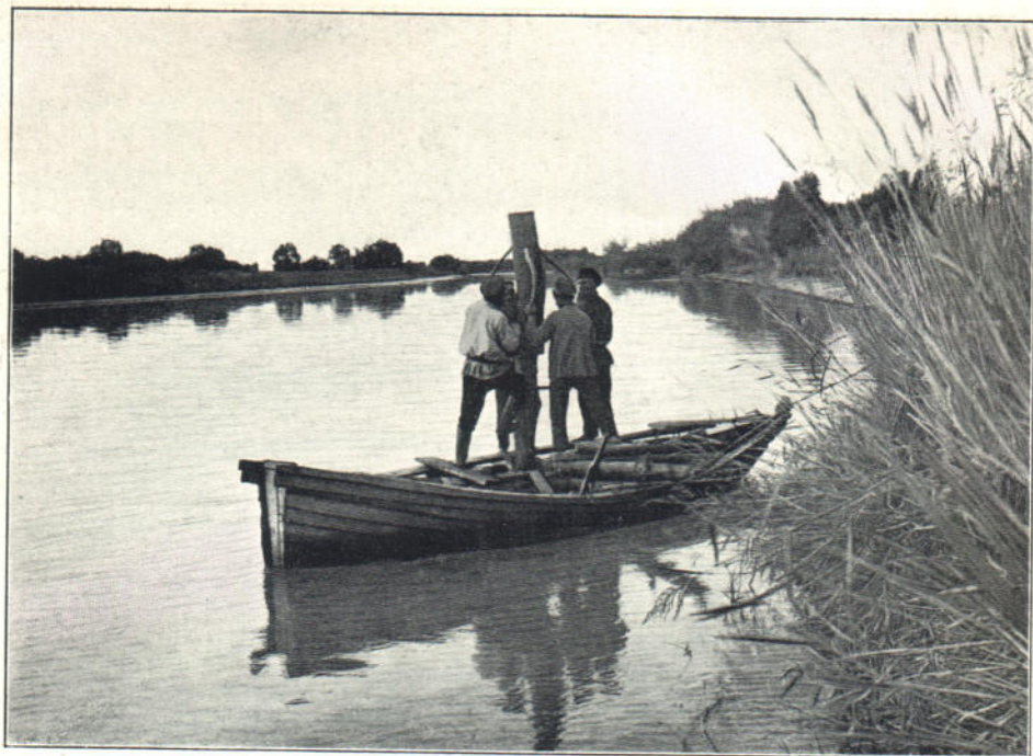
№ 34. Р. Или. Постъ Кайыраганскій. Забивка свай для запасной рейки.
