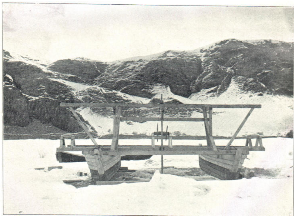
№ 35. Р. Или. Ст. Илійская. Законченный постройкою новый понтонь Илійской станци. На льду по створу.
