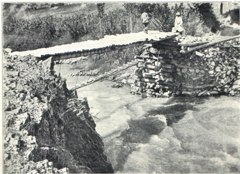
№ 6. Р. Араванъ-сай. Постъ Наукатскій. Гидрометрический мостъ. Видъ внизъ по течению.
