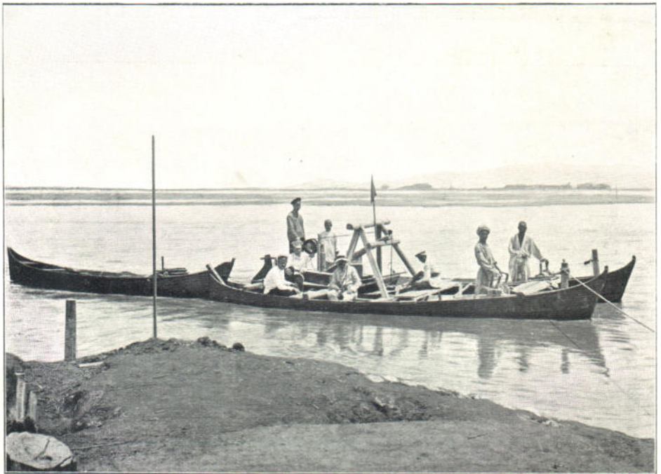
№ 20. Определение расхода и взятие истинных средних пробь.
