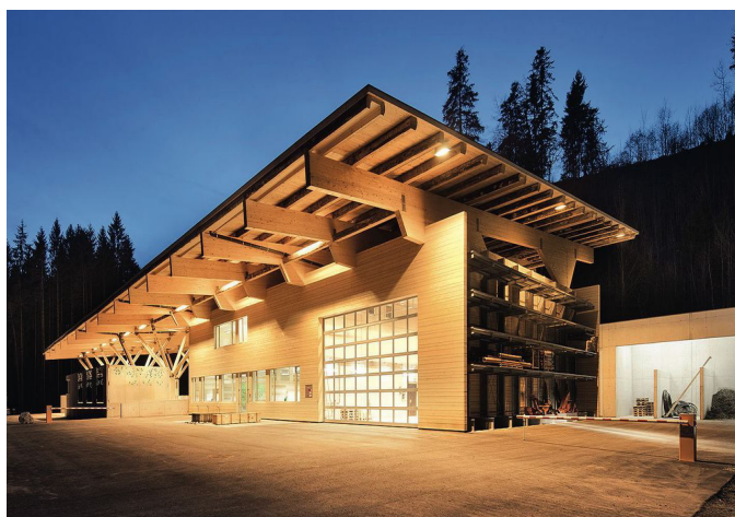
Рисунок 1.3 – Косий згин дерев'яних прогонів: а – у виробничій будівлі; б – у громадській будівлі
