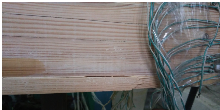
Рисунок 5.17 – Початок руйнування дощатоклеєної балки БДК-2 – тріщина крайньої дошки розтягнутої зони
