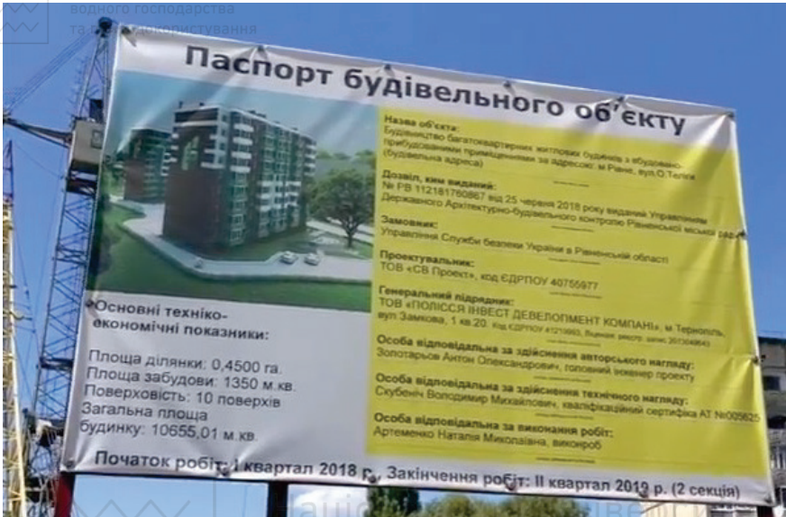
Рис. 5.2. Приклад інформаційного стенду, що встановлюється на будівельному майданчику (паспорт будівельного об'єкта)
