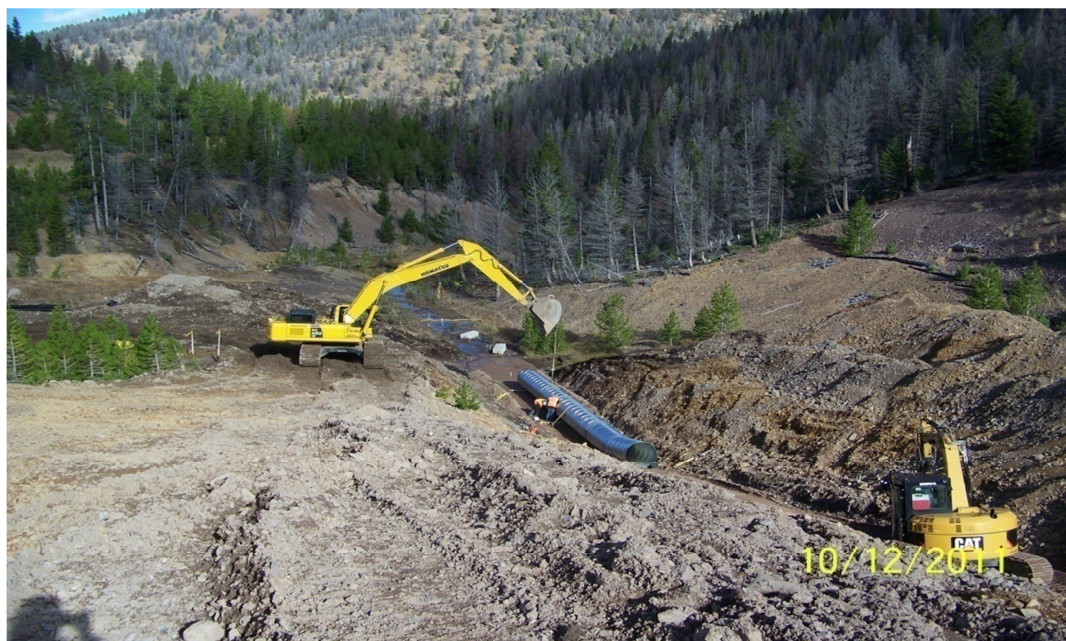
Рисунок 1.3 – Встановлення водоводу через греблю Майк Хорс (США) ( http://pioneer-technical.com/projects/mike-horse-dam/ )
