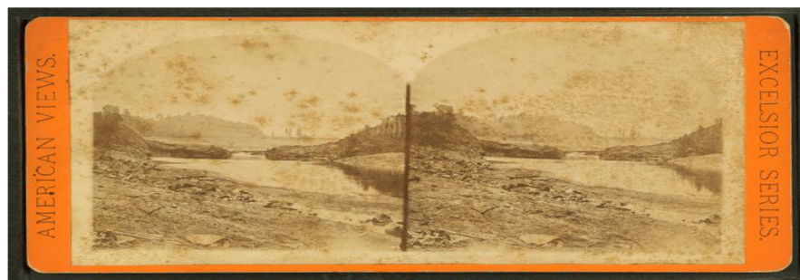
Рисунок 1.16 – Ґрунтова гребля South Fork після катастрофи https://en.wikipedia.org/wiki/South_Fork_Dam#/media/File:Below_dam_looking_up_through_Gap,_from_Robert_N._Dennis_collection_of_stereoscopic_views.jp
