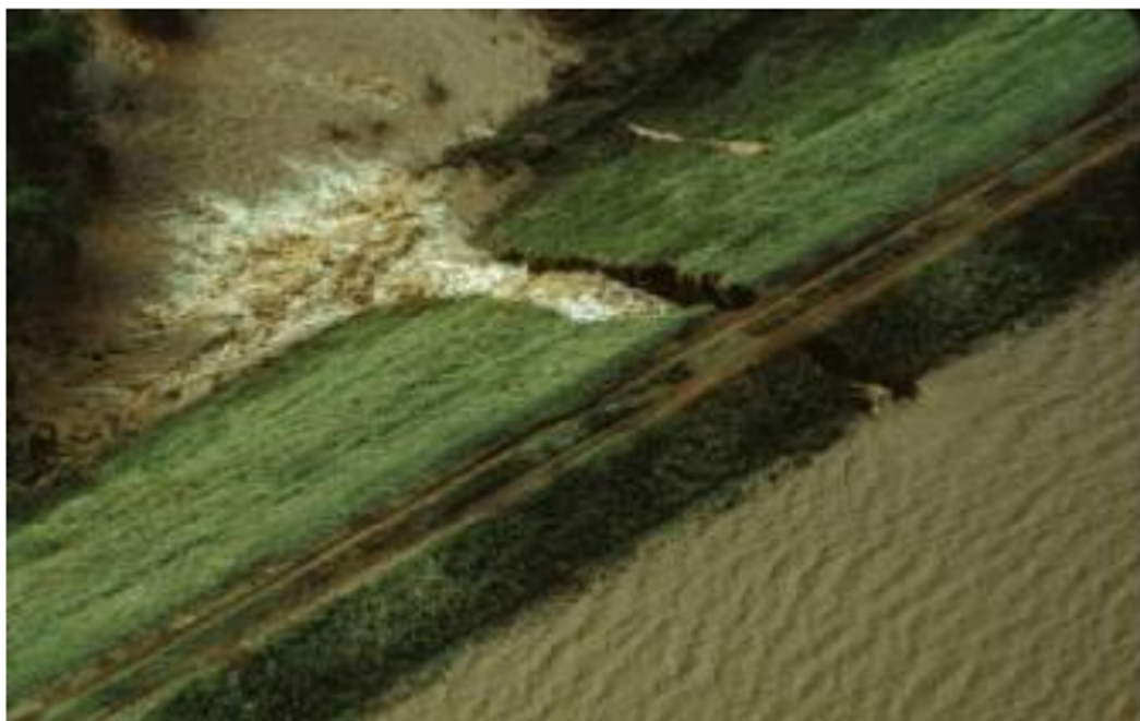
Рисунок 1.18 – Утворення зосередженого шляху фільтрації (110)
