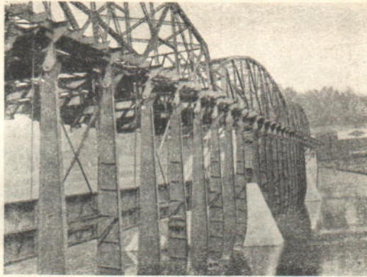
Рис. 56. Плотина на Barge-Canal въ Сѣв. Америкѣ.
