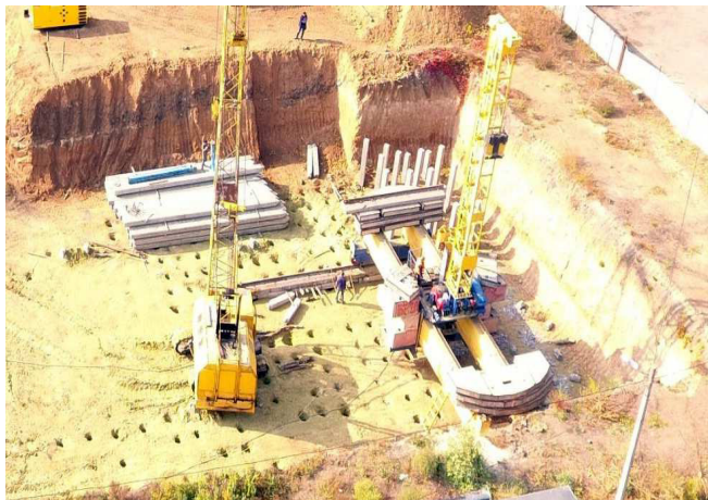
Рис. 2. Процес вдавлення паль на ділянці захватки № 1
