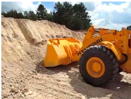
Рис. 1.218. Видалення з площі кар'єру непридатного ґрунту
