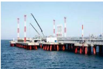
Рис. 3.168. Будівництво споруд піонерним способом
