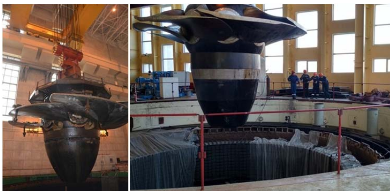
Рис. 3.135. Монтаж робочого колеса гідротурбіни
