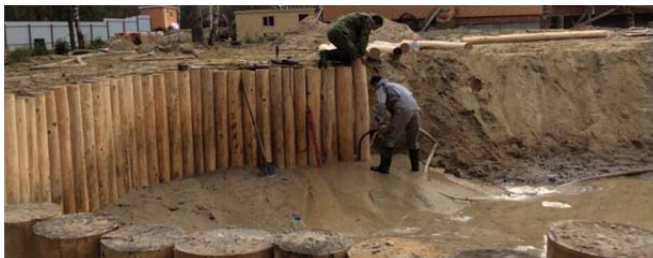
Рис. 3.144. Влаштування дерев'яної шпунтової стінки
