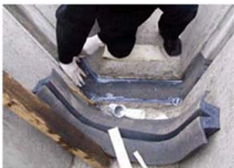
Рис. 1.45. Герметизація шва на каналі гідроактивним компенсатором
