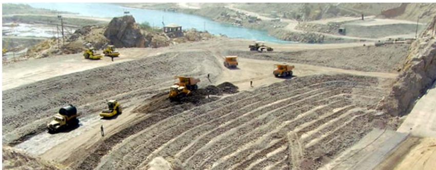
Рис. 1.225. Відсіпання тіла земляної однорідної греблі
