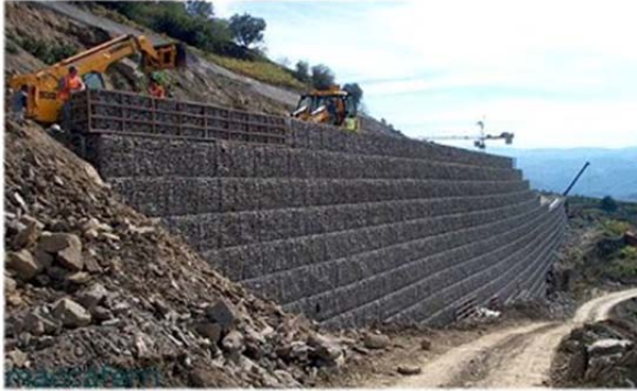
Рис. 2.69. Підпірна стінка з габіонних конструкцій
