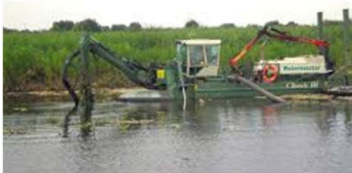
Рис. 1.148. Розробка траншеї на дні річки ґрунтовсмоктуючою установкою (земснарядом)
