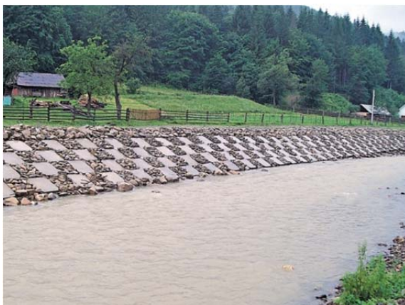
Рис. 2.11. Комбіноване кріплення берега
