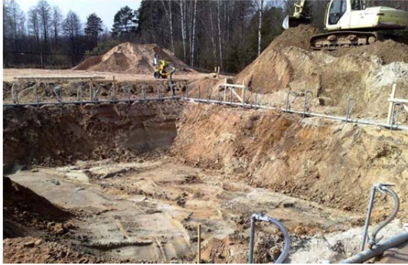
Рис. 1.213. Пониження рівня ґрунтових вод навколо котловану з допомогою голкофільтрової установки
