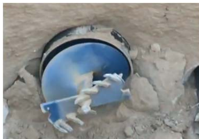
Рис. 1.132. Ріжуча голівка на виході у приймальний котлован
