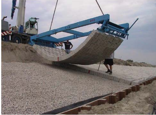
Рис. 2.16. Монтаж універсального бетонного гнучкого мату
