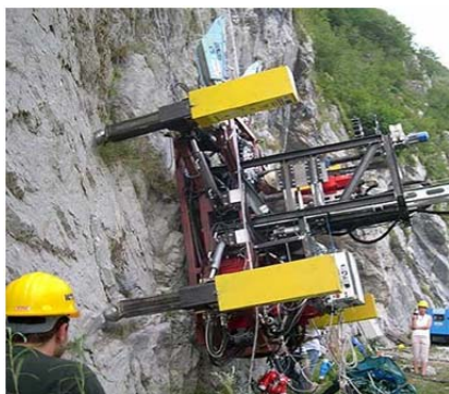
Рис. 5.64. Бурова установка змонтована на роботі – альпіністи
