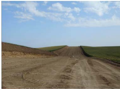
Рис. 1.62. Траса трубопроводу зі знятим рослинним ґрунтом
