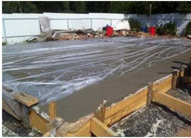
Рис. 3.62. Захист поверхні бетону поліетиленовою плівкою
