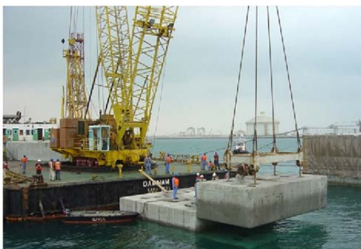
Рис. 3.156. Укладання масивних блоків у споруду
