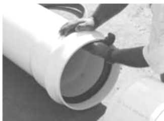
Рис. 1.105. Змащування гумового кільця
