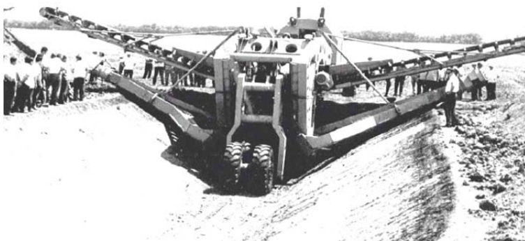
Рис. 1.3. Розробка каналів шнекороторним екскаватором
