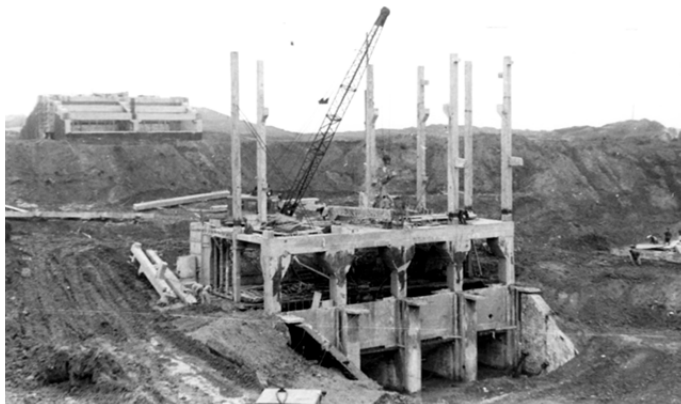
Рис. 1.209. Монтаж збірної частини насосної станції
