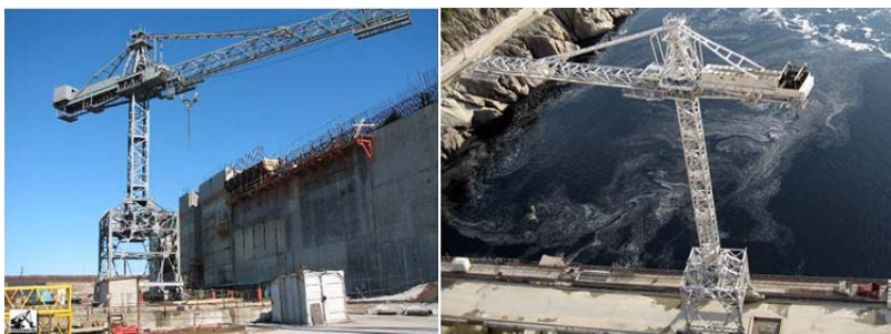
Рис. 3.44. Баштові крани типу КБГС
