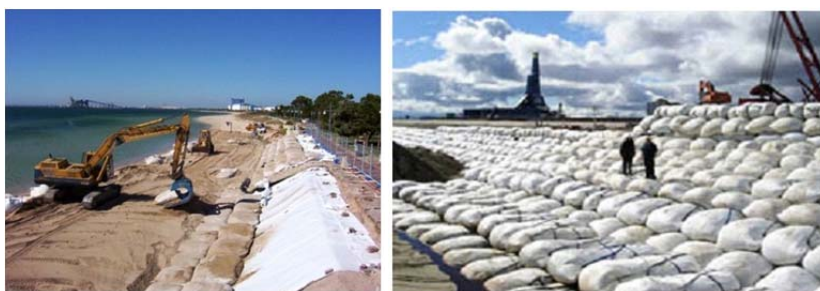
Рис. 2.44. Кріплення берега м'якими контейнерами «Геобег»
