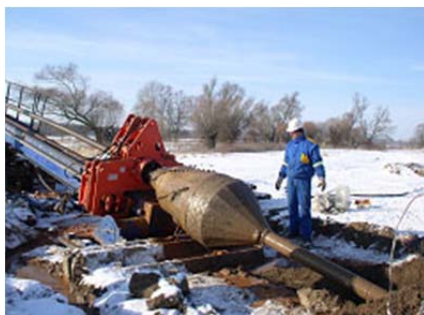
Рис. 1.138. Змонтований на установці ример для розширення
