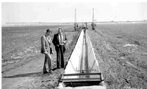
Рис. 1.59. Лотковий канал на опорних плитах
