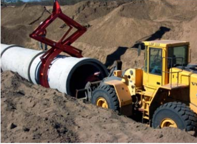
Рис. 1.95. Монтаж залізобетонних труб з допомогою захвата і штовхача
