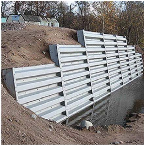
Рис. 2.68. Підпірна стінка зі сталевого профілю
