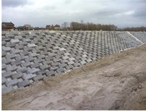
Рис. 2.14. Захист берегу блоками кріплення укисів
