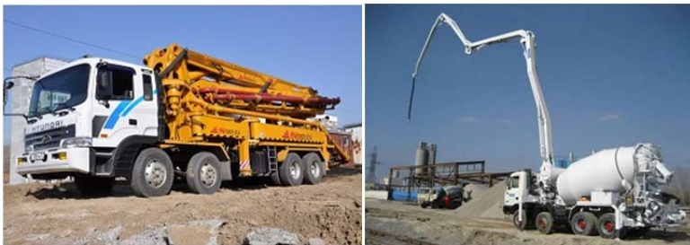
Рис. 3.42. Подача бетонної суміші бетононасосами
