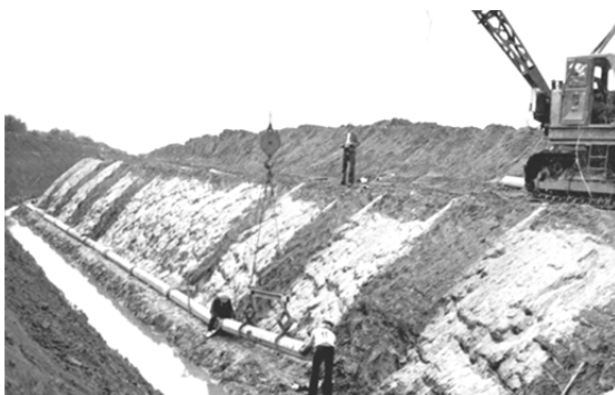
Рис. 1.156. Укладання дренажного колектору з бетонних фальцевих труб на полицю
