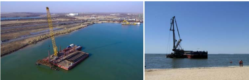
Рис. 3.167. Будівництво причалу з води
