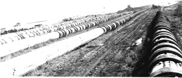
Рис. 1.150. Підготовлені для протягування секції трубопроводу
