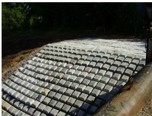
Рис. 2.12. Кріплення укосу універсальними гнучкими бетонними матами
