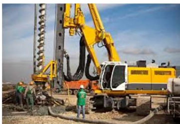
Рис. 3.169. Будівництво причалів методом стіна в ґрунті
