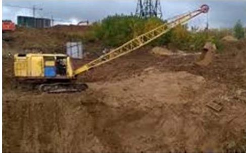
Рис. 1.67. Розробка траншеї екскаватором „драглайн”
