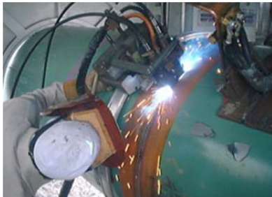
Рис. 1.118. Зварювання труб напівавтоматичною установкою
