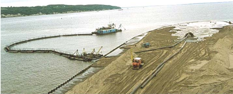
Рис. 2.73. Підвищенням відміток поверхні землі шляхом наміву
