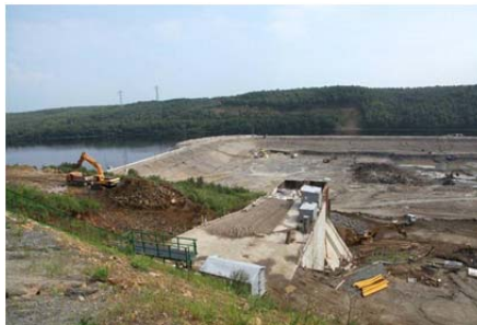
Рис. 3.140. Котлован під основні споруди огорожений перемичками
