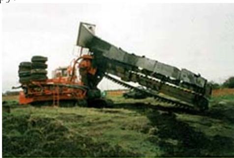
Рис. 1.158. Екскаватор-дреноукладач для влаштування дрен
