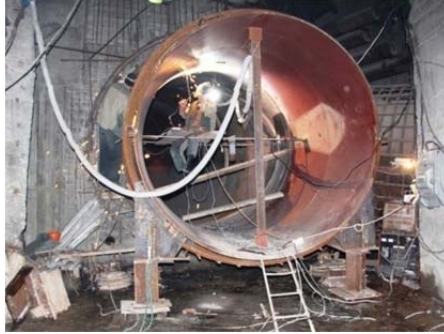
Рис. 3.93. Влаштування комбінованого облицювання: а – виготовлення обичайок; б – зварювання обичайок в тунелі
