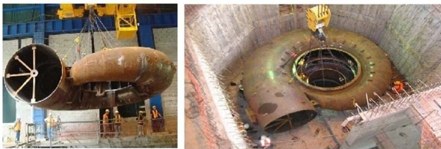
Рис. 3.134. Монтаж литої спіральної камери
