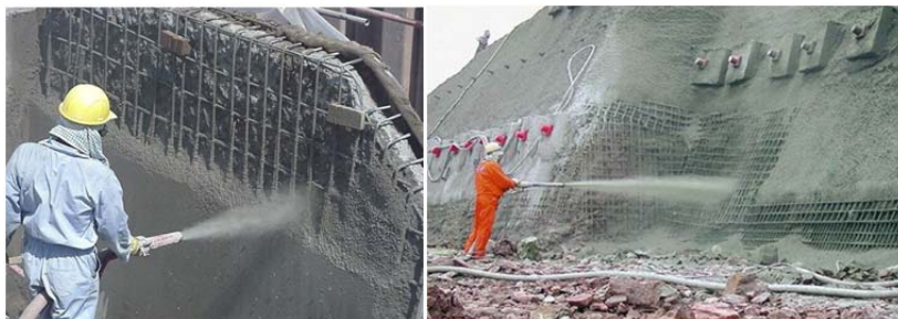
Рис. 3.60. Укладання бетону способом торкретування
