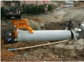
Рис. 1.89. Гідравлічний торцевий захват
