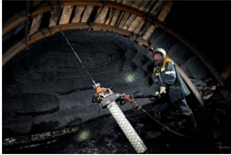
Рис. 3.85. Захист з дощок між арками
