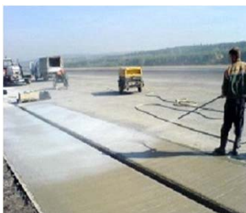
Рис. 3.61. Поливання свіжовкладеного бетону
