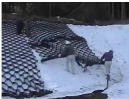
Рис. 2.42. Укладання георешітки на шар геотекстилю
