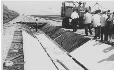
Рис. 1.47. Плівковий екран захищений залізобетонними плитами
