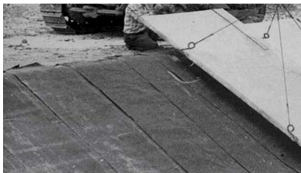
Рис. 1.52. Плівка покрита захисним екраном з пергаменту
