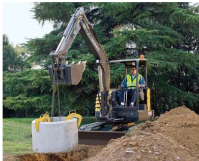
Рис. 1.196. Монтаж залізобетонного колодязя
