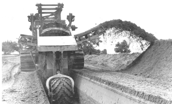
Рис. 1.64. Розробка траншеї з вертикальними стінками роторним екскаватором
