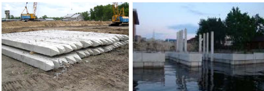
Рис. 2.26. Кріплення берегу залізобетонними паями
