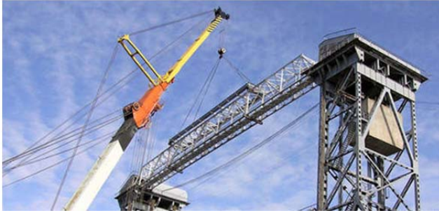
Рис. 3.125. Монтаж прольотних конструкцій з нижніх відміток
