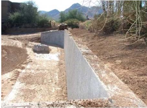
Рис. 2.67. Гравітаційна підпірна стінка з монолітного бетону
