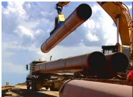
Рис. 1.107. Розвантаження сталевих труб доставлених на будівельний майданчик спеціальним трубовозом
