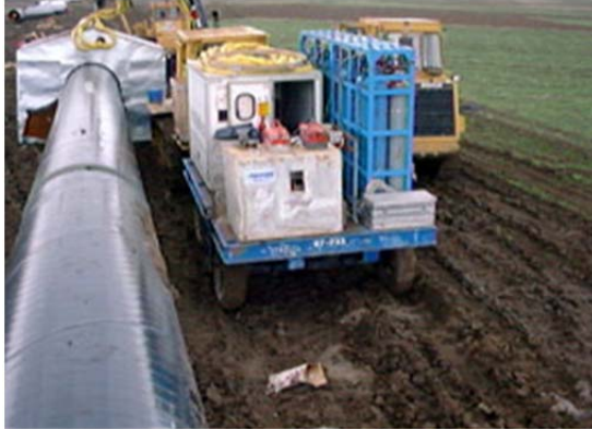
Рис. 1.119. Комплекс для автоматичного зварювання сталевих труб
