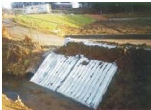
Рис. 2.43. Кріплення укосу геоматрацями
