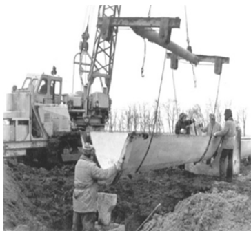
Рис. 1.61. Монтаж лотків з допомогою спеціальної поворотної траверси
