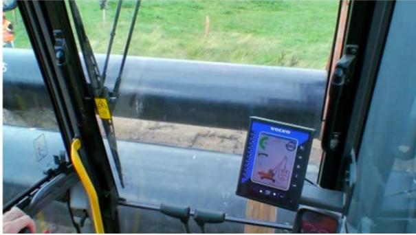
Рис. 1.122. Інформаційна система в кабіні оператора крана-трубоукладача
