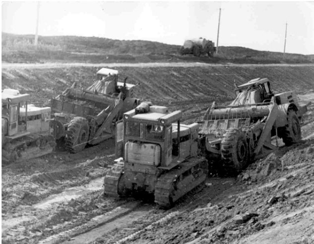
Рис. 1.5. Розробка каналу у виїмці автоскреперами
