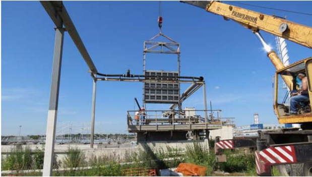
Рис. 3.106. Монтаж затвора будівельно-монтажним краном
