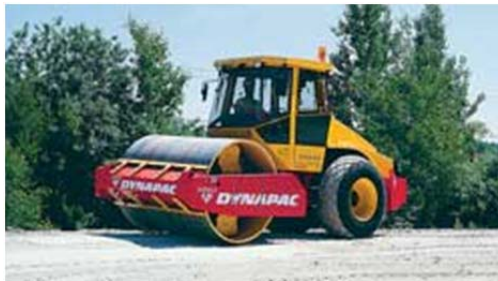
Рис. 1.224. Ущільнення тіла дамби гладковальцьовим віброкотком
