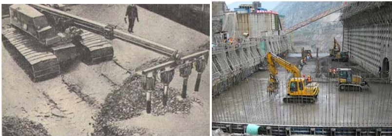
Рис. 3.59. Ущільнення бетонної суміші вібропакетами
