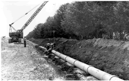
Рис. 1.97. Монтаж азбестоцементних труб за допомогою тракторного крану
