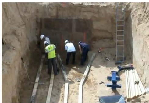
Рис. 1.129. Робочий котлован для розташування обладнання безтраншейної проходки
