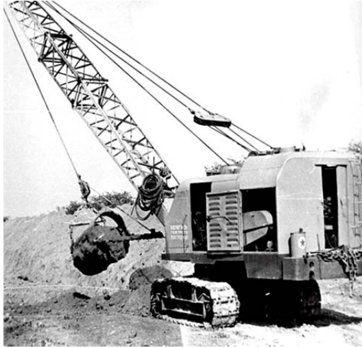
Рис. 1.4. Розробка каналу у виїмці екскаватором драглайн
