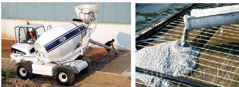
Рис. 3.43. Подача бетонної суміші віброжолобами
