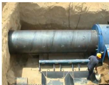
Рис. 1.33. Робітник відкидає розроблений ґрунт від шнекового транспортера
