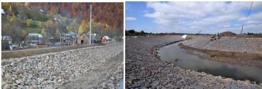
Рис. 2.4. Кріплення берегів відсипкою бутового каменю
