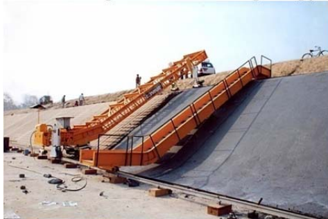
Рис. 1.46. Влаштування монолітного бетонопліткового покриття
