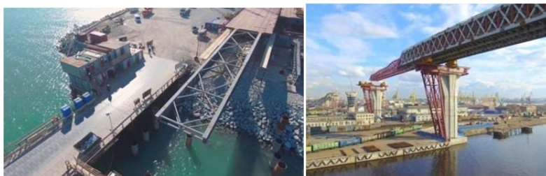
Рис. 3.128. Монтаж пролітних конструкцій мостів методом поздовжнього насування
