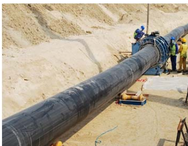
Рис. 1.100. Зварювання пластмасових труб великого діаметра
