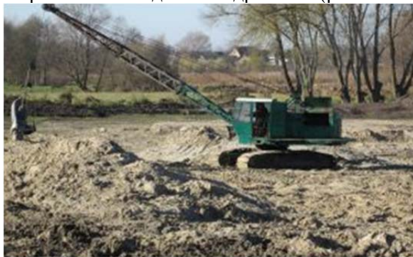
Рис. 1.164. Розробка осушувального каналу екскаватором драглайн
