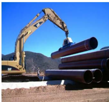
Рис. 1.108. Розвантаження труб вакуумним захватом
