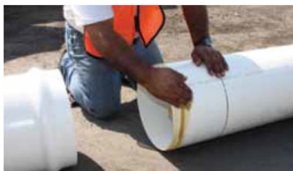
Рис. 1.104. Змащування рідким милом гладкого кінця труби
