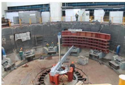
Рис. 3.130. Монтаж елементів гідротурбіни з допомогою поворотної стріли
