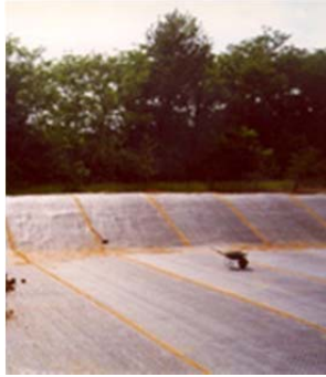
Рис. 1.53. Влаштування гідроізоляційного покриття з бентонітової геомембрани
