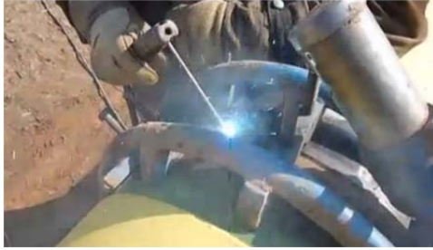
Рис. 1.116. Фіксування торців труб ручним зварюванням через зазори центратора
