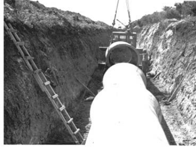
Рис. 1.96. Стикування залізобетонних труб з допомогою бульдозера
