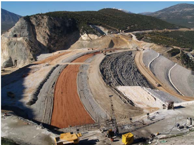
Рис. 1.224. Відсіпання греблі з ядром
