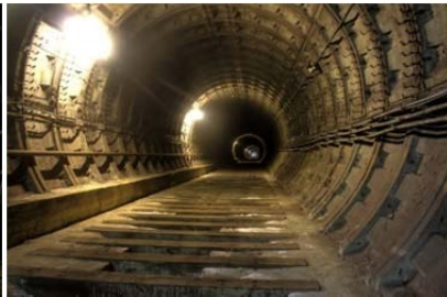
Рис. 3.94. Кріплення тунелів тюбінгами: а – чавунними; б – залізобетонними
