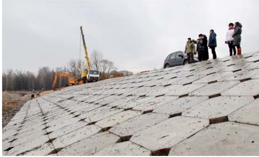
Рис. 1.225. Кріплення верхового укосу греблі залізобетонними плитами
