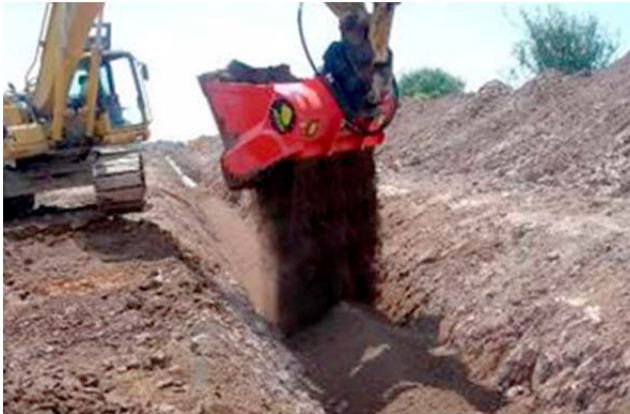
Рис. 1.126. Попереднє засипання траншеї
