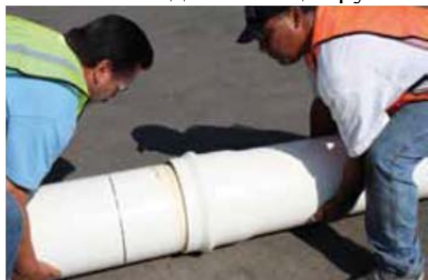
Рис. 1.104. Змащування рідким милом гладкого кінця труби
