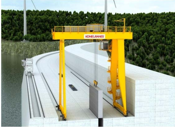
Рис. 3.105. Схема монтажу затвора експлуатаційним козловим краном
