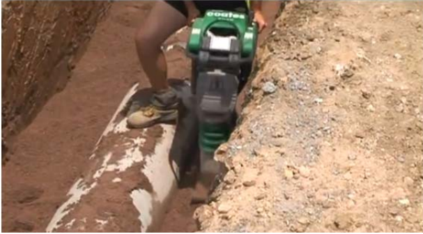
Рис. 1.125. Ущільнення ґрунту в затрубному просторі ручною електротрамбівкою
