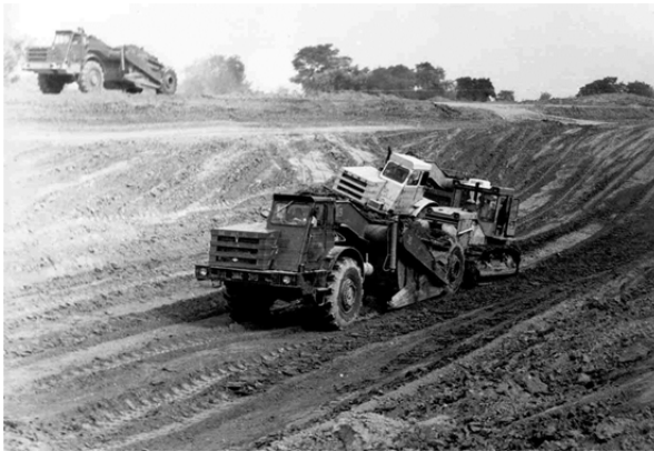
Рис. 1.10. Розробка ґрунту у виїмці каналу з відсипанням його у майбутні дамби
