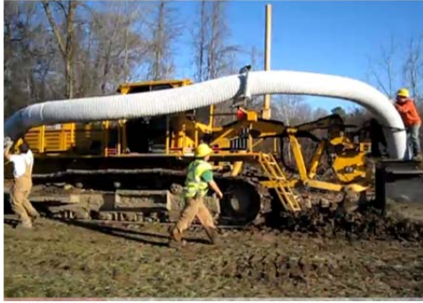
Рис. 1.161. Укладання колектора безтраншейним дрепоукладачем
