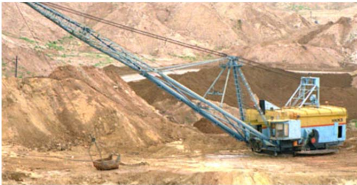
Рис. 1.7. Розробка каналу у глибокій виїмці крокуючим екскаватором
