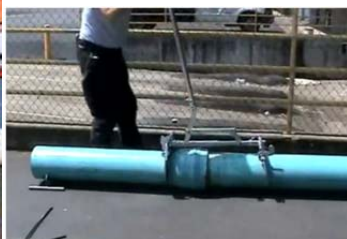
Рис. 1.106. З'єднання розтрубних пластмасових труб за допомогою натяжного пристрою
