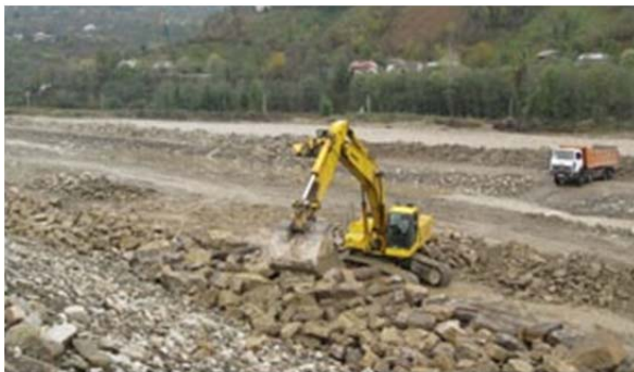
Рис. 2.7. Улаштування кам'яної відсипки екскаватором
