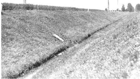
Рис. 1.169. Кріплення осушувального каналу хмизовим плотом і обдернуванням
