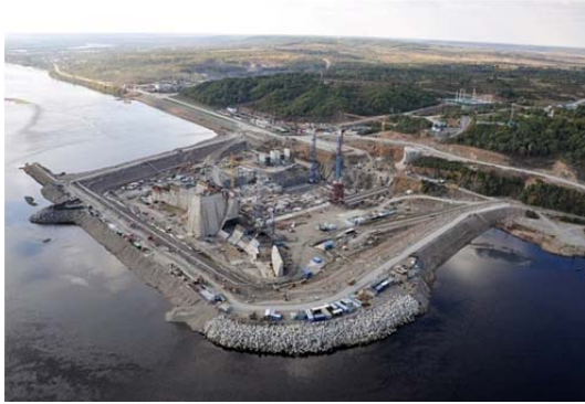
Рис. 3.136. Будівництво споруд гідровузла під захистом перемичок
