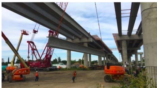
Рис. 3.127. Монтаж пролітних конструкцій мостів будівельно-монтажними кранами
