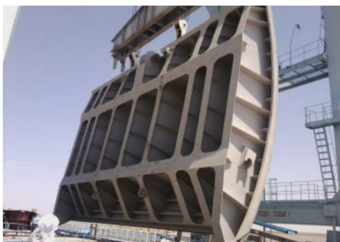
Рис. 3.110. Монтаж пролітної частини сегментного затвору
