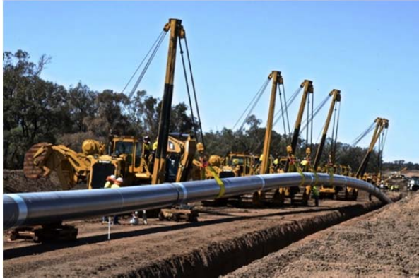
Рис. 1.124. Укладання сталевго трубопроводу методом безперервної нитки
