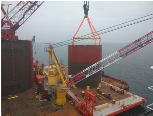
Рис. 3.175. Подача секції оболонки великого діаметру
