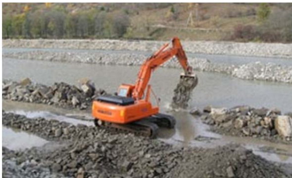
Рис. 2.5. Видобування каменю у руслі ріки На укосах призначених для кам'яної відсипки влаштовується з допомогою бульдозерів підготовка з гравію (рис. 2.6).
