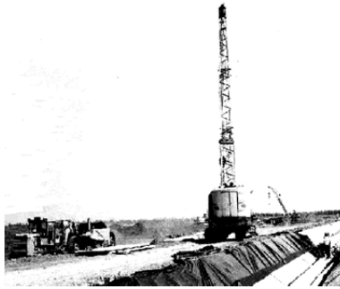
Рис.1.33. Монтаж облицовання з залізобетонних плит гусеничним стріловим краном
