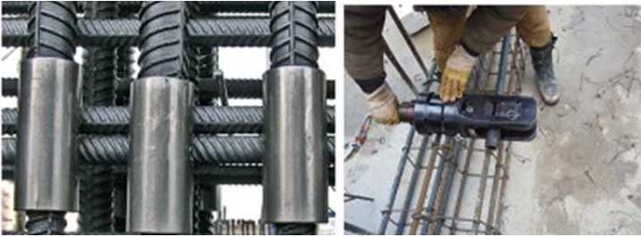
Рис. 3.35. З'єднання арматури з допомогою муфт
