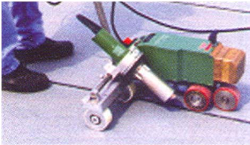
Рис. 1.49. Пристрій для зварювання плівок гарячим повітрям
