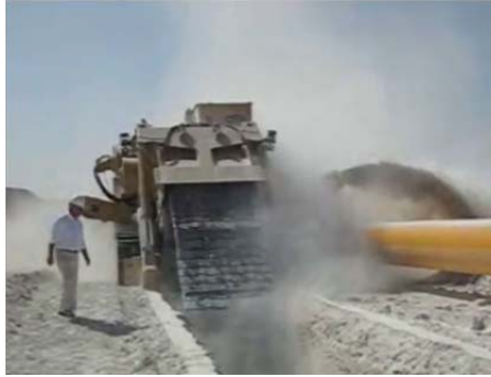
Рис. 1.65. Розробка траншеї стрічковим екскаватором безперервної дії
