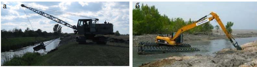
Рис. 1.162. Регулювання водоприймачів: а – екскаватором-драглайн; б – екскаватором-амфібією
