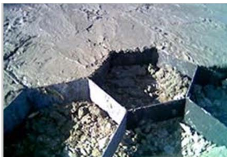
Рис. 2.40. Заповнення георешітки бетоном
