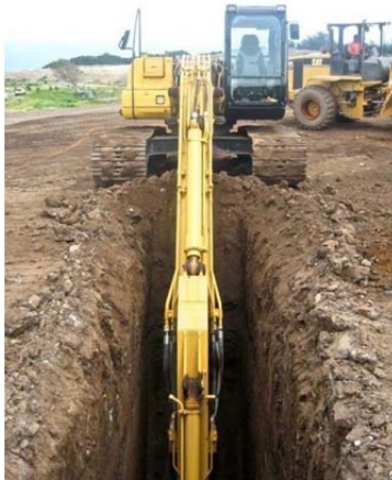
Рис. 1.68. Розробка траншеї екскаватором „зворотна лопата”
