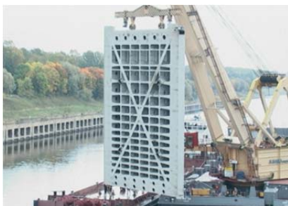
Рис. 3.114. Монтаж стулки шлюзових воріт заводської зборки
