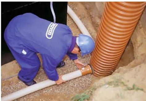
Рис. 1.181. Полімерний колодязь для промивання дренажів
