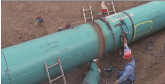
Рис. 1.117. Формування стикового шва вручну
