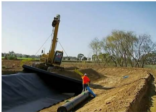
Рис. 1.54. Влаштування облицювання каналу з поліетиленової геомембрани
