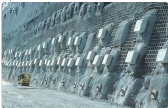
Рис. 2.61. Анкерування підпірної стінки гвинтовими анкерами
