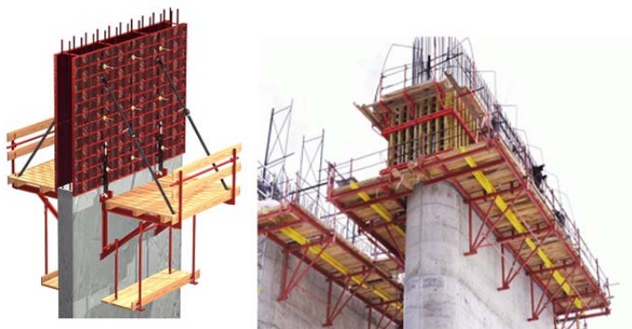
Рис. 3.26. Ковзна опалубка
