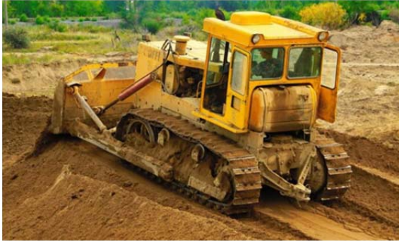
Рис. 1.127. Остаточне засипання траншеї
