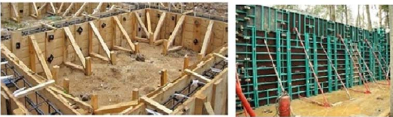
Рис. 3.23. Збірно-розбірна щитова опалубка
