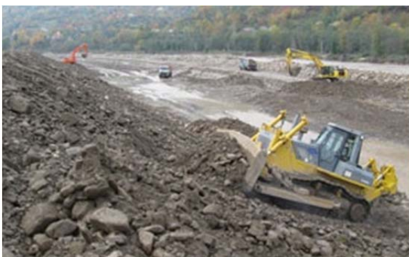
Рис. 2.6. Влаштування підготовки з гравію бульдозером
