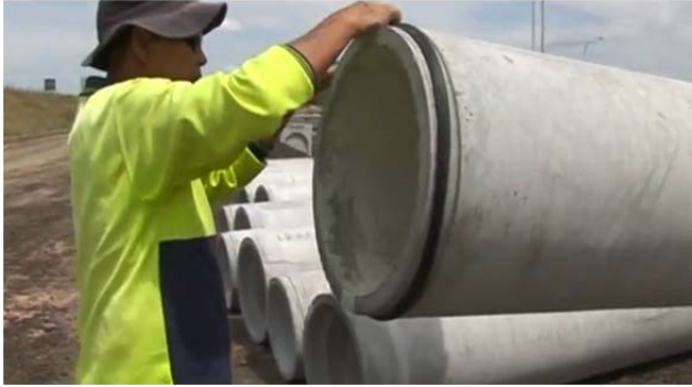
Рис. 1.93. Одягання гумового кільця на гладкий кінець залізобетонної труби
