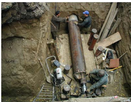
Рис. 1.143. Процес проходки способом проколювання
