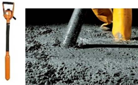
Рис. 3.58. Ущільнення бетонної суміші глибинним вібратором
