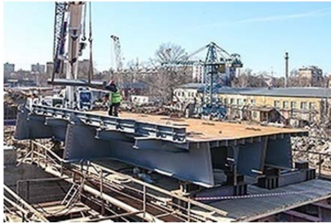
Рис. 3.126. Збирання пролітної конструкції на підмостях
