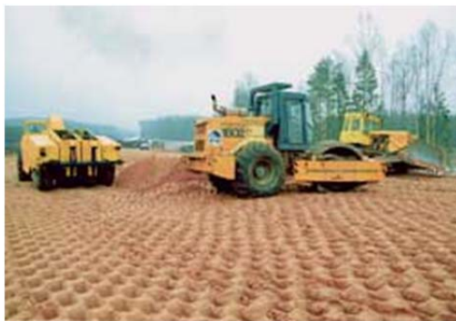
Рис. 1.222. Пошарове ущільнення тіла дамби кулачковим вібрототками
