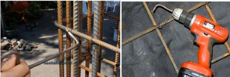
Рис. 3.36. З'єднання арматури в'язальним дротом
