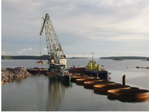
Рис. 3.176. Заповнення оболонок піском
