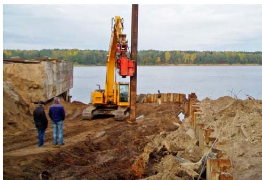
Рис. 3.145. Влаштування стінки зі сталевго шпунта
