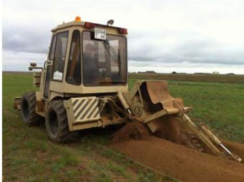
Рис. 1.65. Розробка траншеї стрічковим екскаватором безперервної дії
