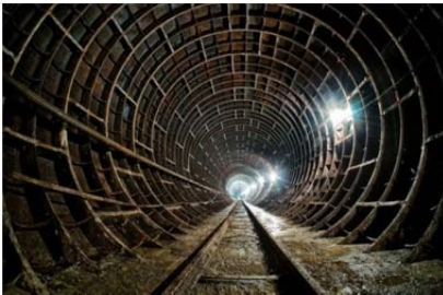
Рис. 3.94. Кріплення тунелів тюбінгами: а – чавунними; б – залізобетонними
