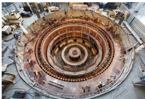
Рис. 3.131. Монтаж статора гідротурбіни
