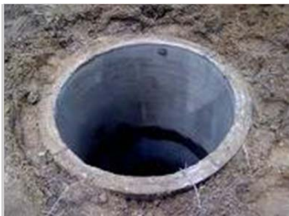
Рис. 1.180. Колодязь з залізобетонних кілець
