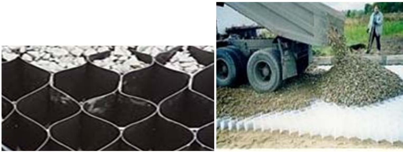
Рис. 5.39. Заповнення георешітки щебенем
