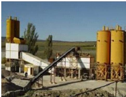
Рис.3.38. Двоступенева бетонозмішувальна установка
