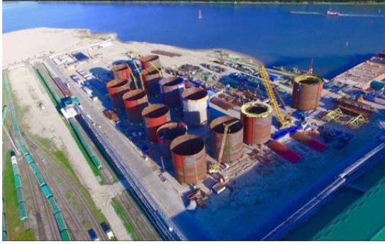
Рис. 3.174. Збирання секцій оболонок великого діаметру
