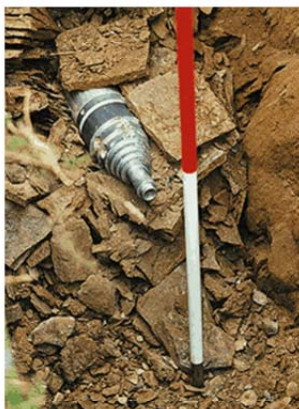
Рис. 1.144. Вихід пневмоударної машини в приймальний котлован
