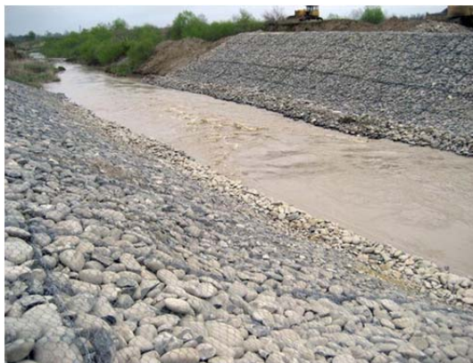
Рис. 2.22. Кріплення берегів річки матрацами Рено
