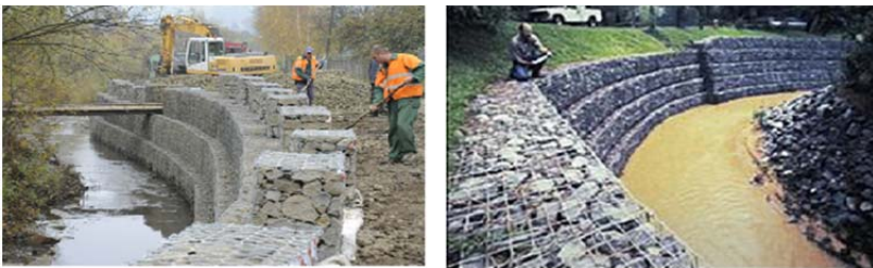
Рис. 2.21. Кріплення берегів стінками з габіонних конструкцій
