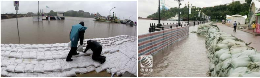
Рис. 2.81. Захисні дамби з мішків наповнених піском або ґрунтом
