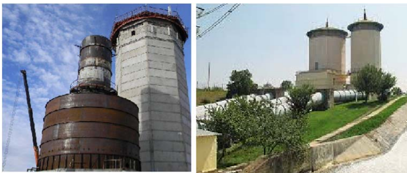
Рис. 3.123. Монтаж вирівнювальних резервуарів
