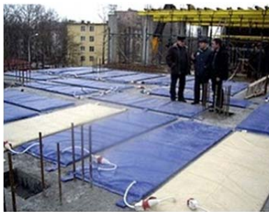
Рис. 3.63. Прогрівання бетону електричними гріючими матами
