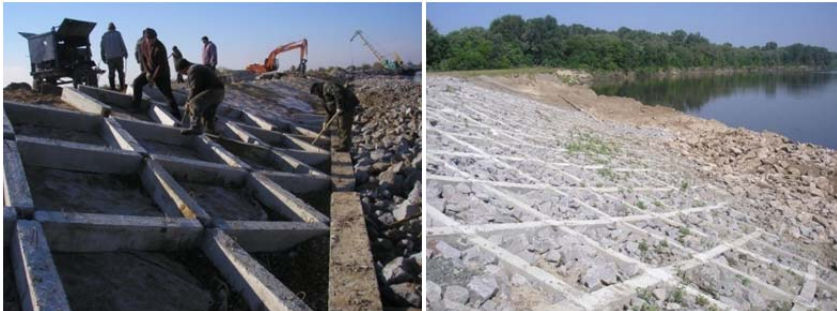
Рис. 2.10. Кріплення берега збірними залізобетонними решітчастими конструкціями: а – влаштування решітчастого залізобетонного кріплення; б – заповнення комірок кріплення каменем
