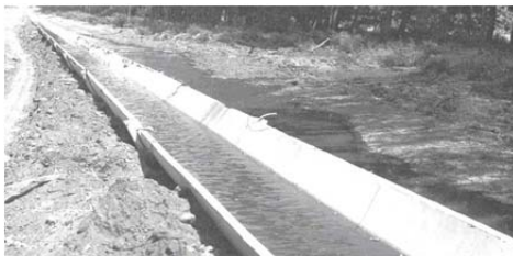
Рис. 1.60. Гідравлічні випробування лоткового каналу на опорних плитах
