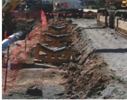
Рис. 1.110. Лежаки для укладання труб
