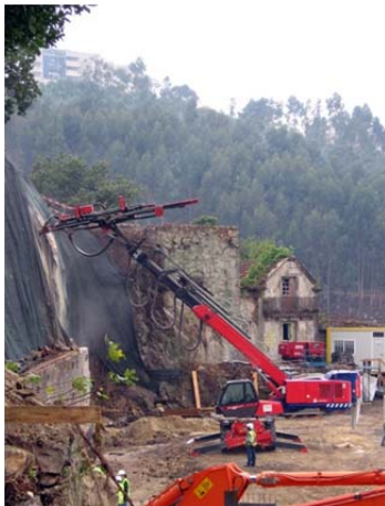
Рис. 2.63. Бурова установка закріплена на стрілі екскаватора
