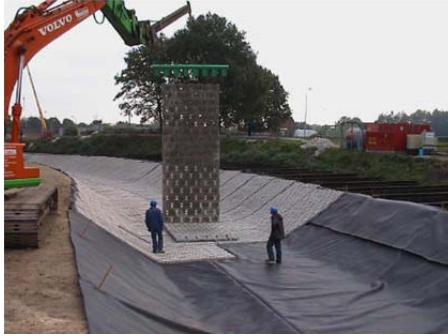
Рис. 1.1.55. Захист мембранного покриття універсальними гнучкими бетонними матами
