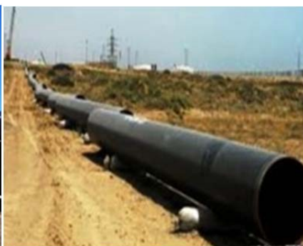
Рис. 1.109. Розкладання труб вздовж траншеї
