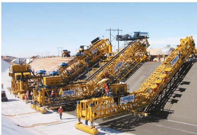
Рис. 1.27. Напівпрофільний бетоноукладальний комплекс для облицювання магістральних каналів
