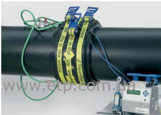
Рис. 1.102. Зварювання труб електрозварною муфтою
