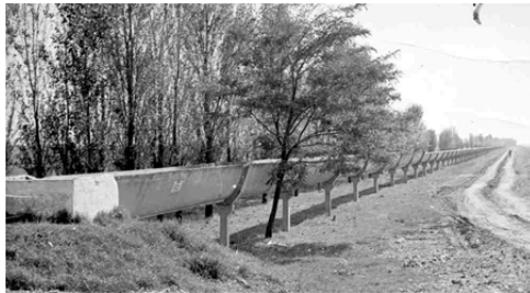
Рис. 1.58. Лотковий канал на опорних стійках
