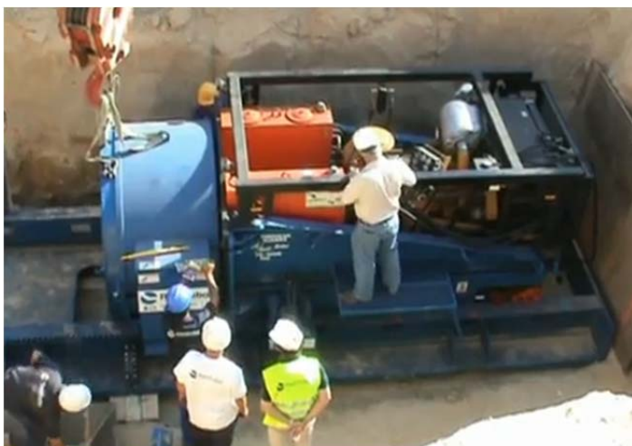
Рис. 1.134. Монтаж установки горизонтального буріння
