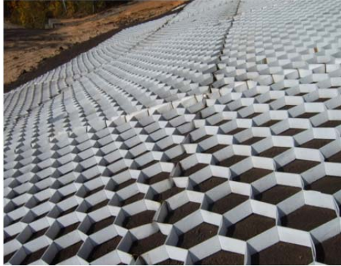
Рис. 1.226. Кріплення укосу греблі георешітками
