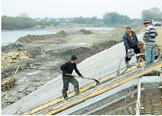
Рис. 2.9. Кріплення укосу водозахисної дамби монолітними залізобетоном
