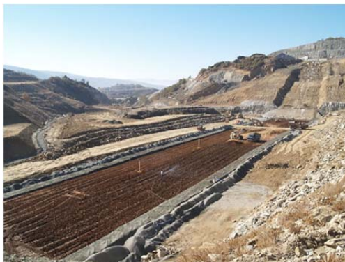
Рис. 1.217. Підготовка основи під земляну греблю
