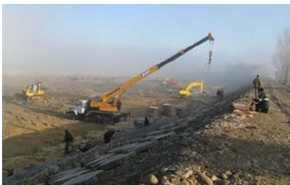
Рис. 2.8. Кріплення укосу водозахисної дамби збірними залізобетонними плитами
