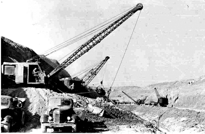
Рис. 1.6. Розробка ділянки каналу Дніпро – Донбас у глибокій виїмці (фото 1962 року)
