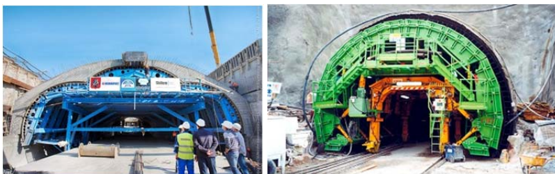
Рис. 3.27. Котюча опалубка
