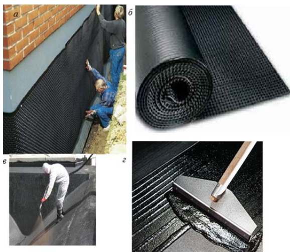
Рис. 2.94. Гідроізоляція підземних частин будівель і споруд:
