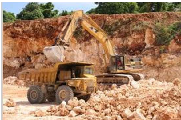
Рис. 1.220. Розробка ґрунту в кар'єрі боковим вибоєм
