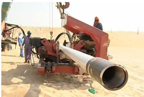
Рис. 1.79. Тонкостінна сталева труба з привареною обичайкою
