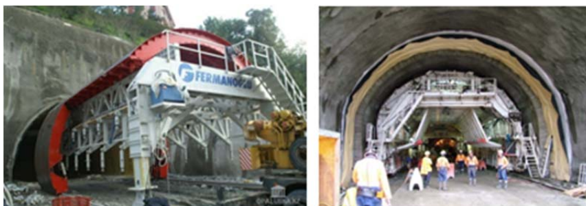
Рис. 3.91. Механізована опалубка для облицювання тунелів
