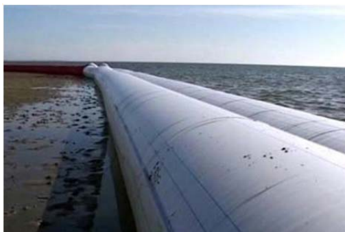
Рис. 2.85. Водоналивна протипаводкова дамба
