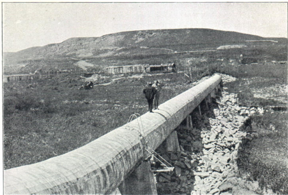
Фиг. 18. Предприятие рѣки Сонъ въ шт. Монтана. Обратный сифонъ изъ желѣзо-бетона на главномъ каналѣ предприятия. Длина сифона 1.500 ф., внутренней діаметръ 61½ дюймовъ, наибольший напоръ воды 51 ф.
