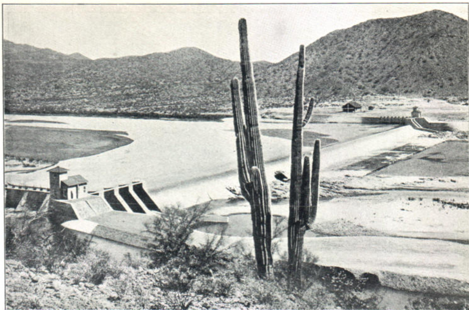
Фиг. 7. Предприятие рѣки Солтъ въ шт. Аризона. Бетонная водосливная плотина „Гранитный Рифъ“ (Granite Reef Dam), расположенная въ руслѣ рѣки на 120 в. ниже плотины Рузвельта.
