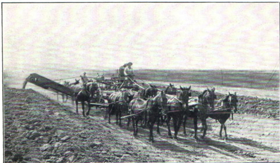
Фиг. 23. Предприятие Бель Фуршъ въ шт. Ю. Дакота. Прорытіе главнаго канала предприятия при помощи спеціальныхъ землекопныхъ машинъ (elevator-graders).
