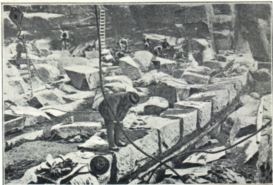
Фиг. 29. Предпріятіє долины рѣки С. Платты. Начало постройки плотины Пасфайндеръ.
