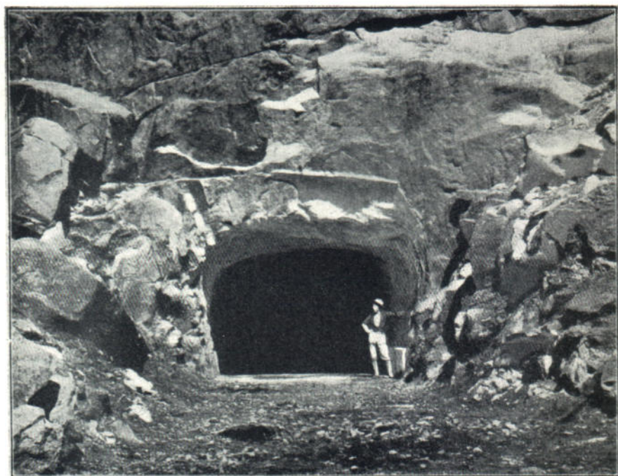
Фиг. 30. Предпріятіє долины рѣки С. Платты. Нижній тоннель для выпуска воды изъ резервуара Пасфайндеръ.
