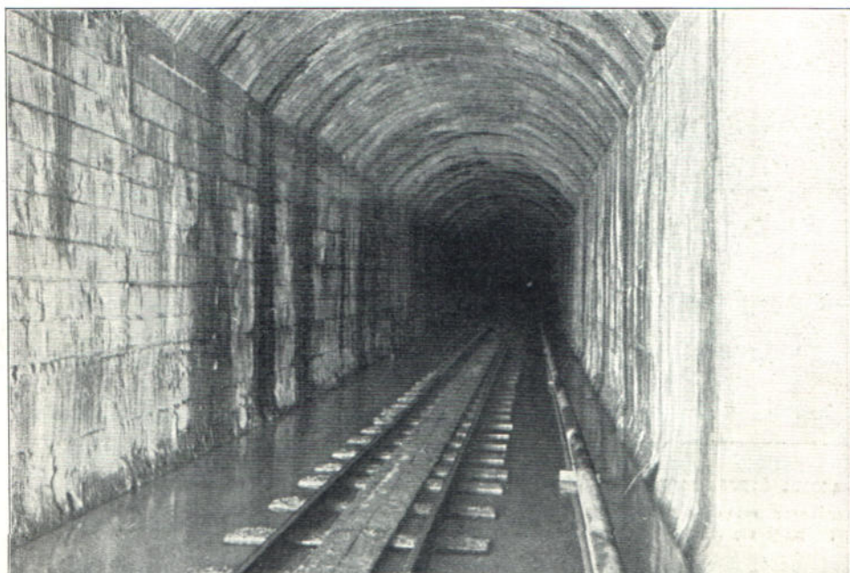
Фиг. 13. Предприятие Ункомпаге в шт. Колорадо. Видъ въ туннель во время постройки.
