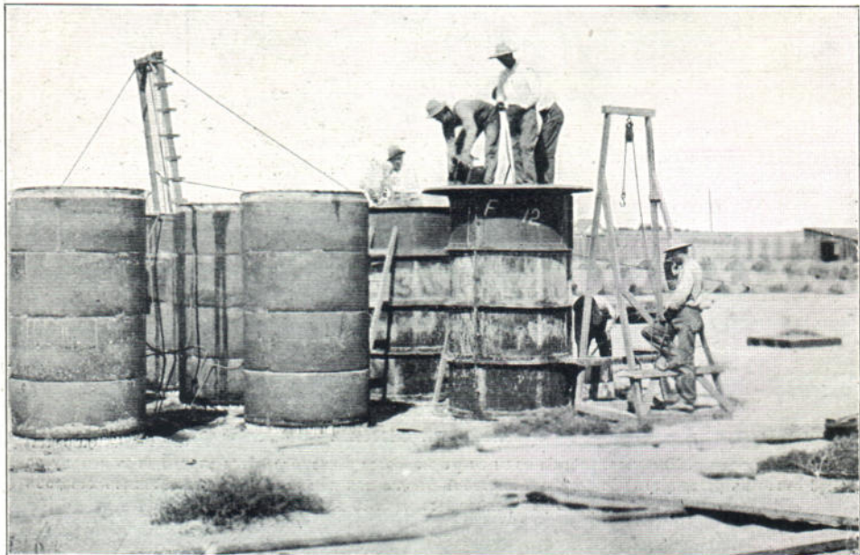
Фиг. 22. Предприятие Юматилла в шт. Орегонь. Формовка желѣзо-бетонныхъ трубъ.
