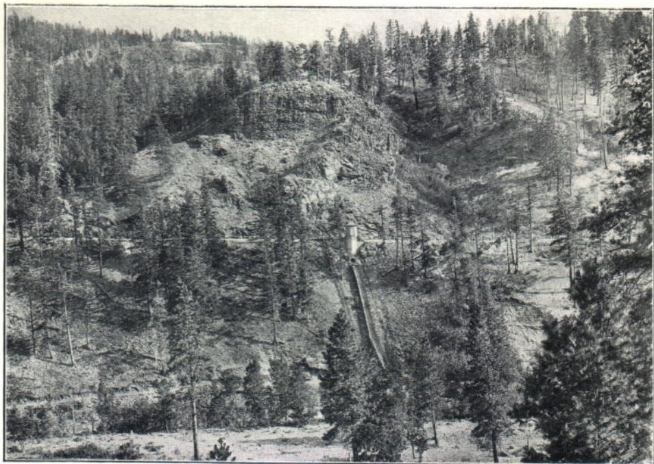
Фиг. 3. Предприятие Тайетонъ въ шт. Вашингтонъ. Главный каналъ предприятия, проходящій по косогорамъ на протяженіи 18 верстъ въ желѣзо-бетонномъ желобѣ.
