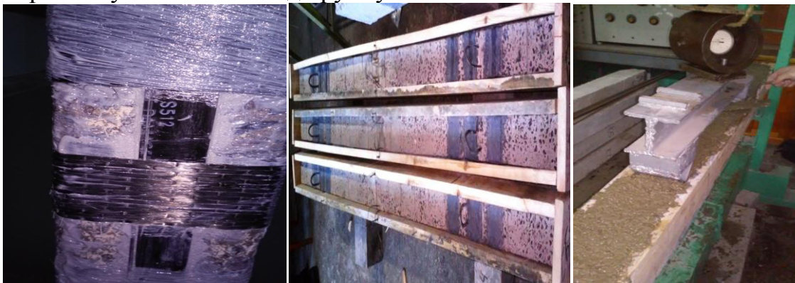
Рисунок 4 – Приклеювання стрічки Sika® CarboDur® S-512 та підсилення стиснутої зони залізобетонних балок
