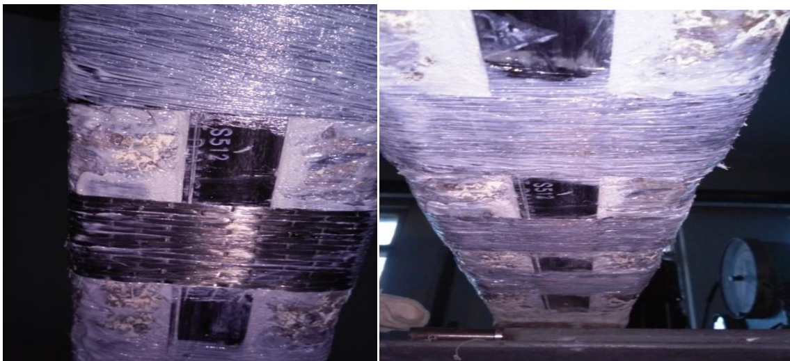
Рисунок 2.12 –Ламінування другого шару SikaWrap® під навантаженням
