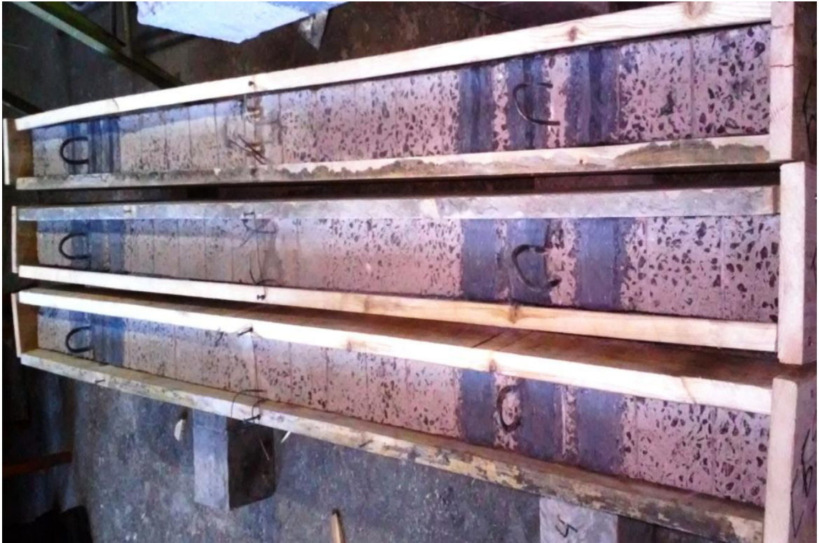
Рисунок 2.15 – Улаштування опалубки на балках
