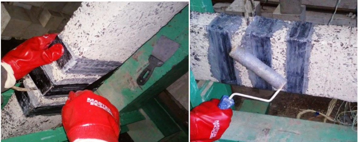
Рисунок 2.9 – Наклеювання першого шару та вкатування полотна Sika Wrap®
