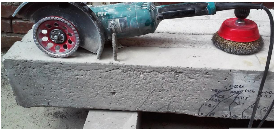
Рисунок 2.3 – Підготовка поверхні бетону балки до підсилення
