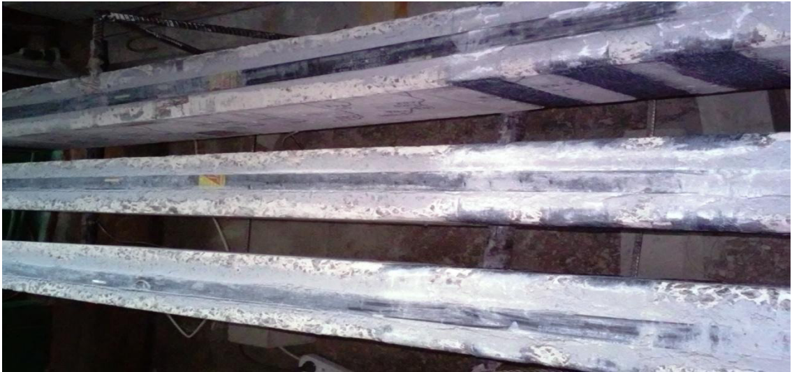
Рисунок 2.11 – Підготовка балок до приклеювання другого шару SikaWrap®
