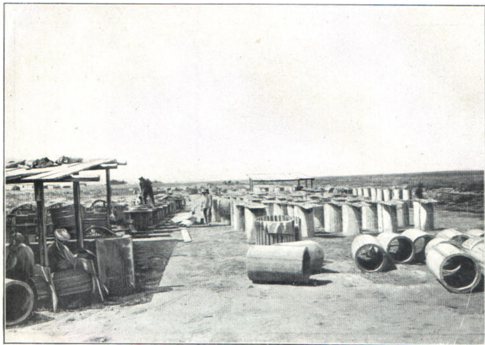
Заводская заготовка желѣзо-бетонныхъ трубъ при разъѣздѣ „Золотая Орда“ Ср. Азіатск. ж. д.
