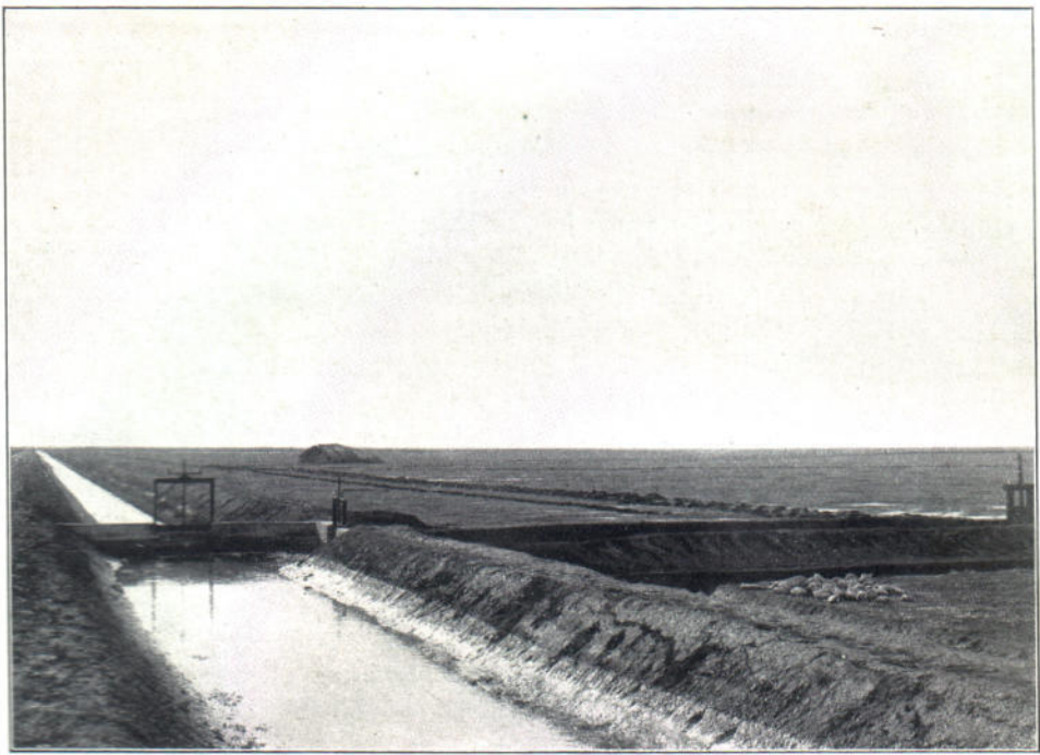
Перегораживающее сооружение на каналѣ.
