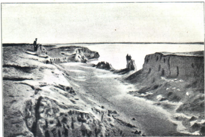
Размывъ канала Императора Николая I Сыръ-Дарьей на 30-й верстѣ, у озера Алка-куль въ 1910 г. Видъ внизъ по теченію.
