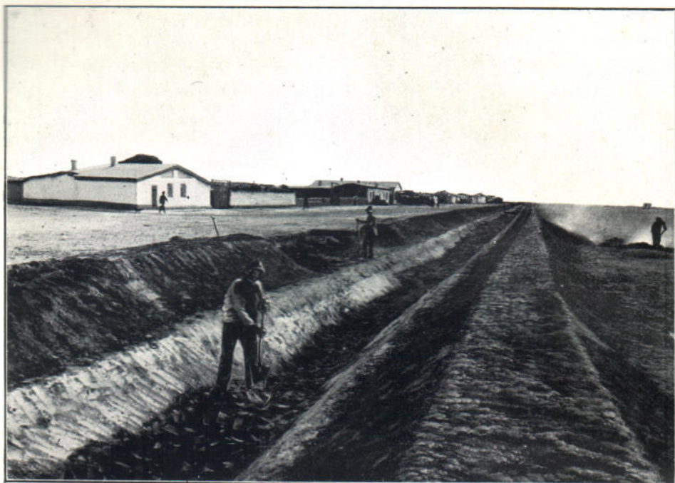
Улица поселка Нахаловки и работы по проведению канала вдоль линии жел. дороги къ ст. Сыръ-Дарьинской.
