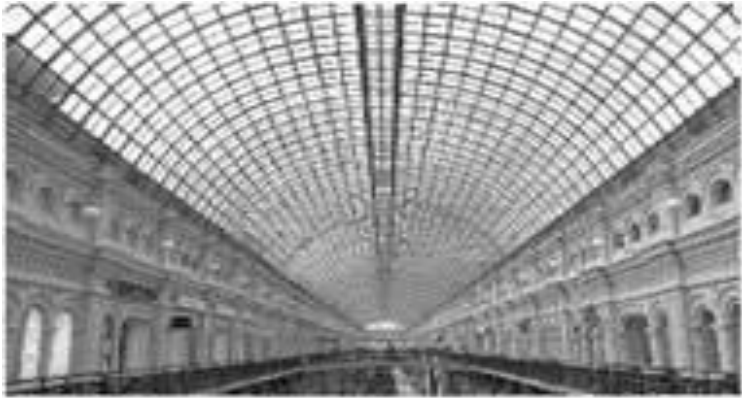
Рис. 1.3. Безарочне склепіння В.Г. Шухова
