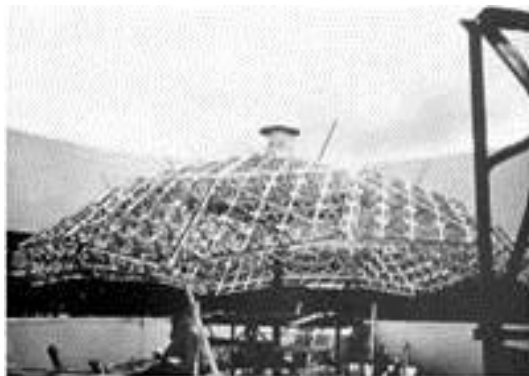
Рис. 1.1. Алюмінієвий купол системи "Октет Трас" Р.Б. Фуллера
