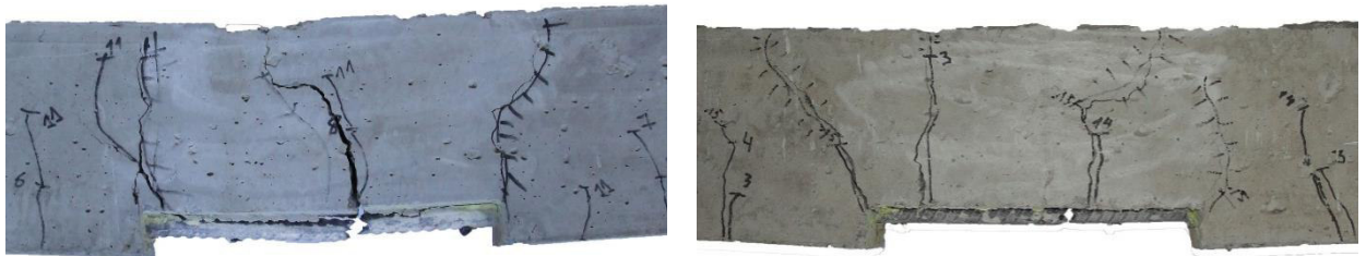
Рис. 3.34. Характер утворення тріщин центрального перерізу дослідного зразка БП-1.3 (зліва) та БП-1.4 (справа)
