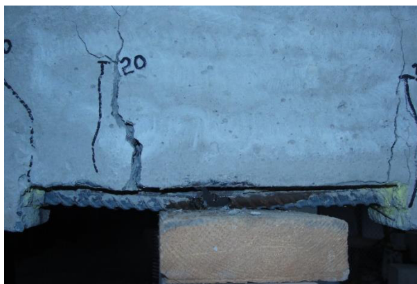
Рис. 3.15. Руйнування зразка БП-3.16-0.5, внаслідок розриву робочої арматури
