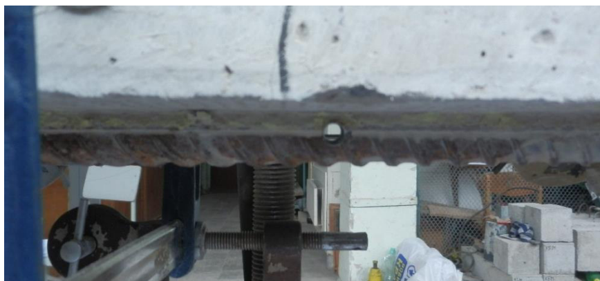
Рис. 2.11. Загальний вигляд одиночного отвору у робочій арматурі пошкоджених зразків
