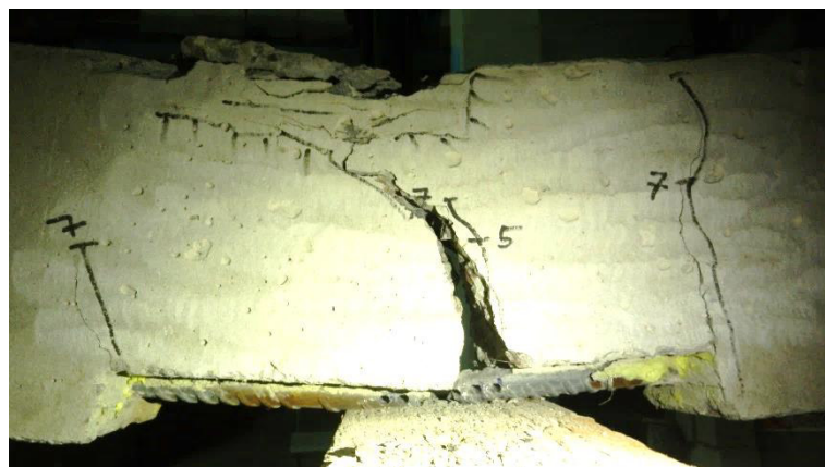
Рис. 3.11. Руйнування зразка БП-1.9-0.5*, внаслідок розриву робочої арматури
