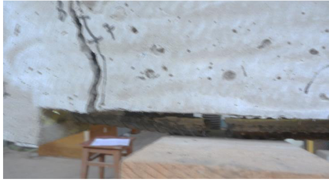
Рис. 3.13. Руйнування зразка БП-1.11-0.7, внаслідок розриву робочої арматури
