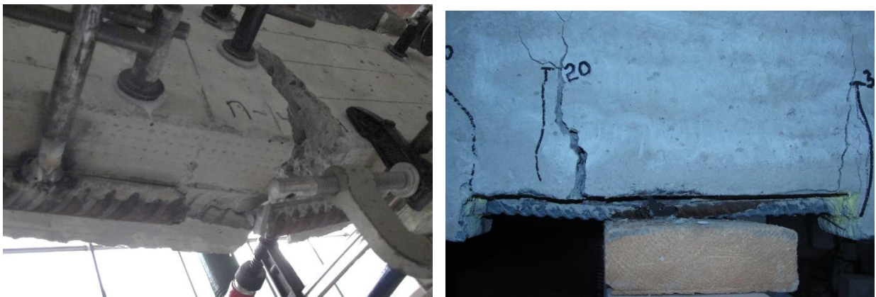
Рис. 4. Типовий характер руйнування балок 1-ї серії з пошкодженою робочою арматурою
