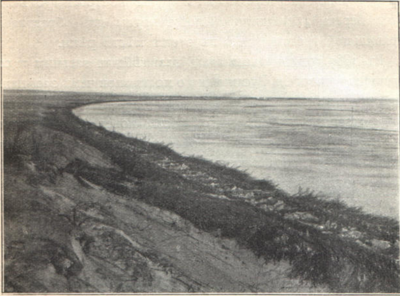
Рис. 27.—Фашинная обдѣлка, служащая для укрѣпленія праваго берега р. Днѣпра въ 3-хъ верстахъ выше Кіевской пристани (1886 г.).
