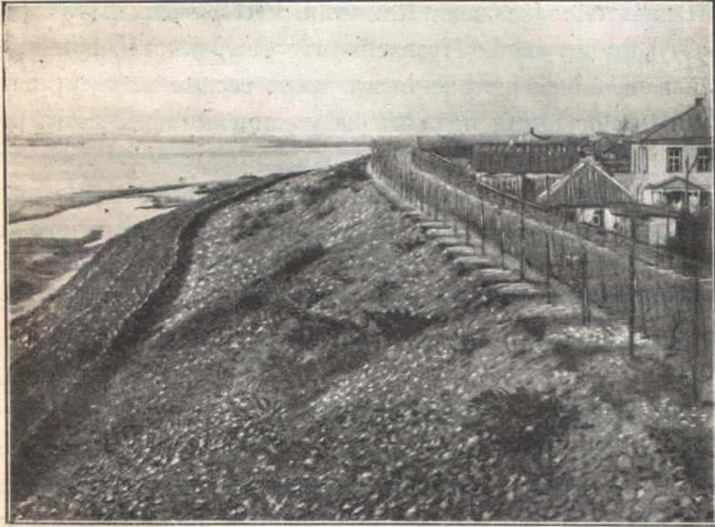
Рис. 32.—Незаотпляемая струнаправляющая дамба на лѣвомъ берегу Днѣпра, примыкающая къ устью пѣннаго моста. (Къ работамъ у Кіева—1896 г.).
