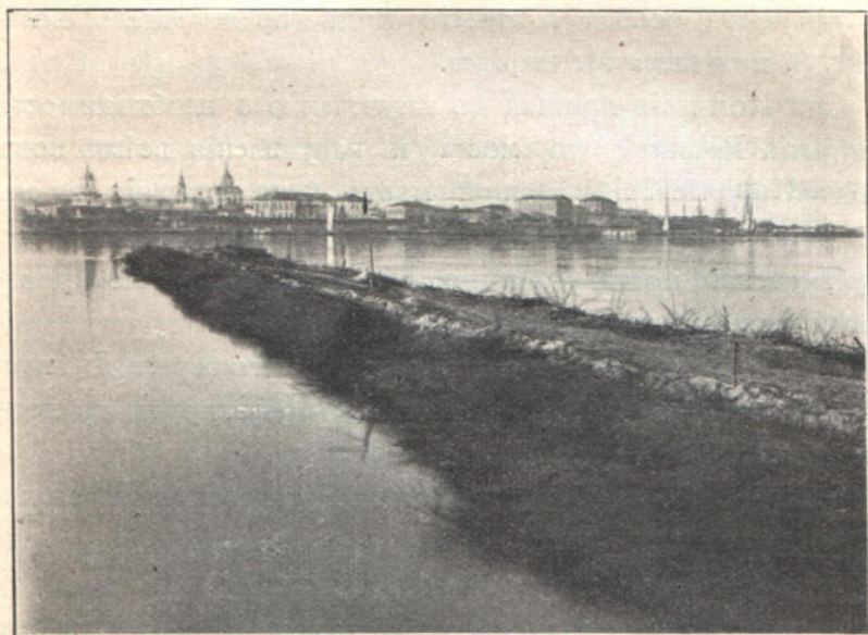
Рис. 29.—Четырнадцатая полузапруда, служащая для защиты берега и отклонения фарватера къ городскому берегу (1887 г.).
