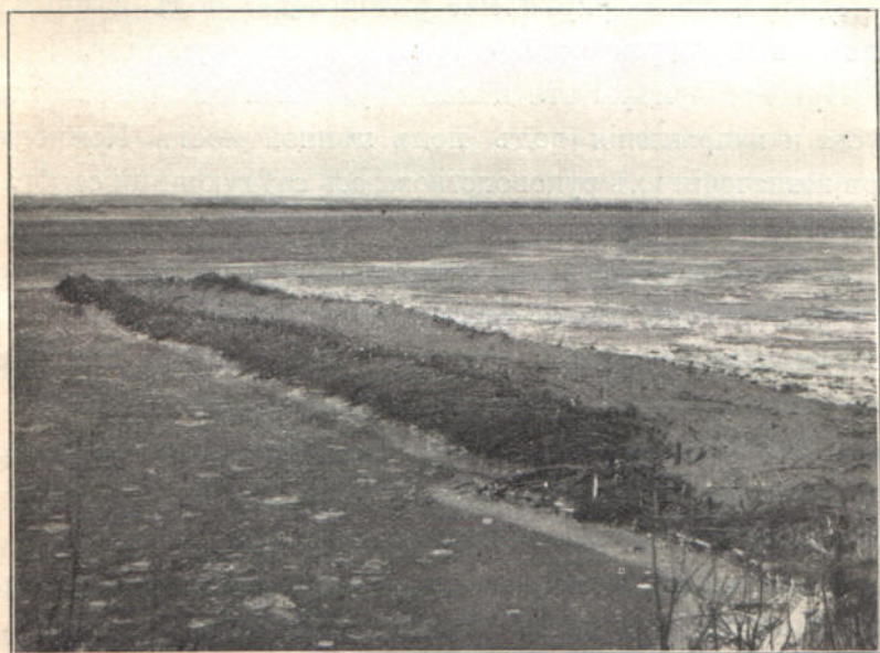
Рис. 30.—Шестая полузапруда, служащая для отклонения воды отъ Черто- ройскихъ сооружений и Труханова острова (1888 г.).
