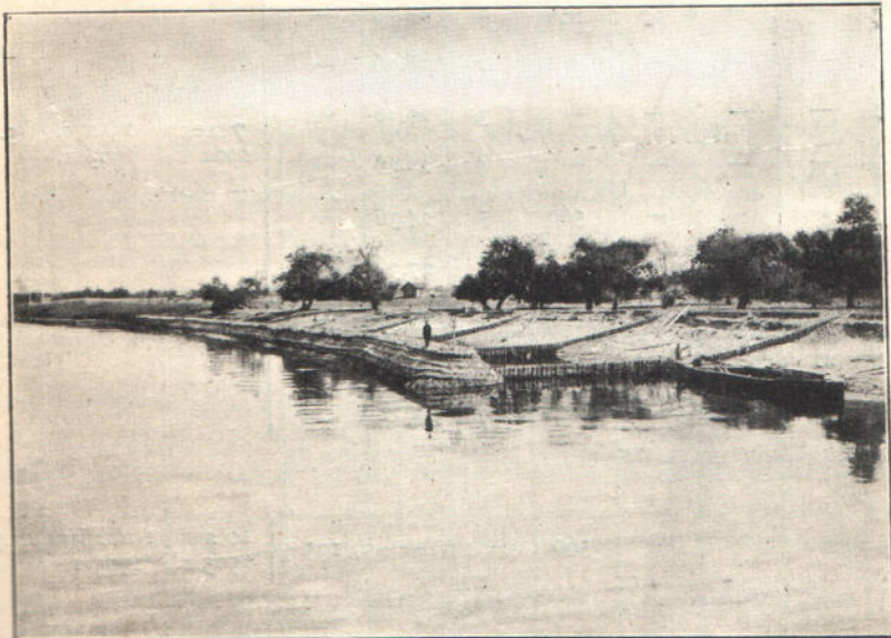
Рис. 22. Струенаправляющая дамба у лѣсной пристани „Смычекъ“ на Верхнемъ Днѣпрѣ.
