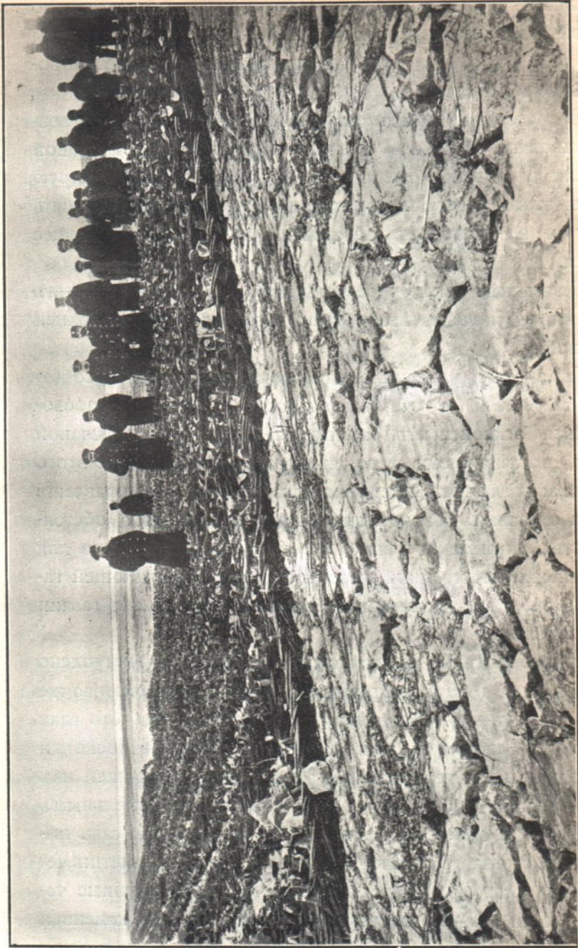
Рис. 37.—Видь укрѣпленія лѣваго берега р. Днѣпра у г. Александровска метловою фашиною покрывшкою и каменною одеждою (1896 г.).
