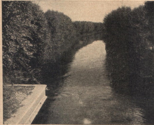
Рис. 2. Главный каналъ Валуйскаго уч. по выходѣ изъ водохранилища.
