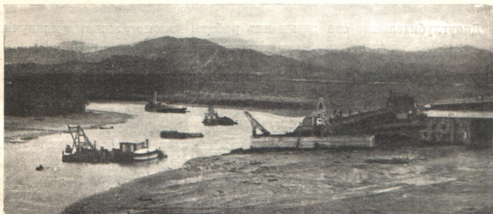
Рис. 52. Работы по подводной разработкѣ скалистаго грунта въ призмѣ Канала.
