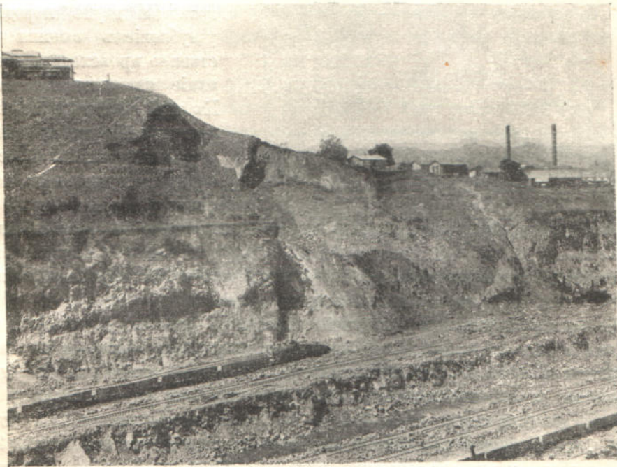
Рис. 48. Видъ сдвига, или оползня второй категоріи.
