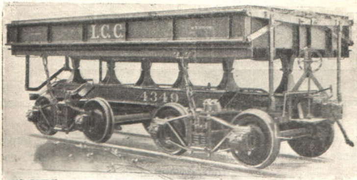
Рис. 20. Типъ вагона съ кузовомъ, опрокидывающимся вручную.
