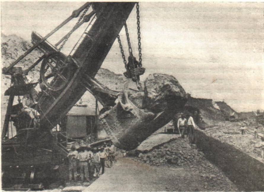
Рис. 15. Нагрузка осколка скалы вѣсомъ 500 пудовъ на желѣзнодорожную платформу опрокидываніемъ поверхъ ковша.
