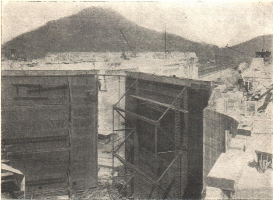
Рис. 133. Шлюзные ворота въ сборкѣ и поддерживающія ихъ вспомогательныя фермы.
