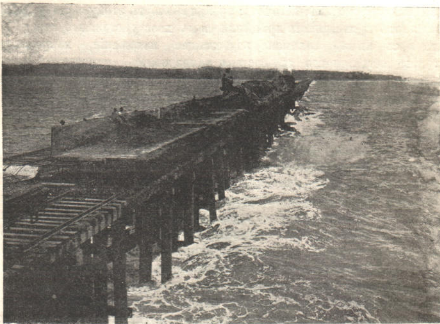
Рис. 34. Разгрузка плугомъ состава изъ однобортныхъ платформъ при отсыпкѣ мола.
