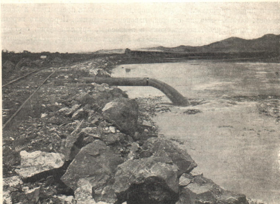
Рис. 76. Боковая каменная часть плотины и выпускъ рефулерной линіи, питающей ядро ея. (Этотъ рисунокъ заимствованъ изъ труда профессора В. Е. Тимонова „Мировой водный путь черезъ Панамскій Перешеекъ“).
