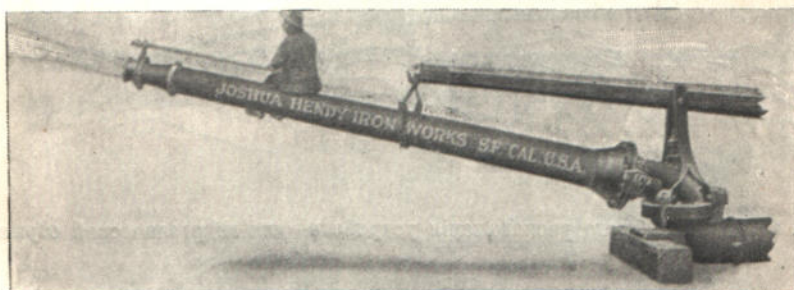
Рис. 66. Наконечникъ гидравлическаго экскаватора
