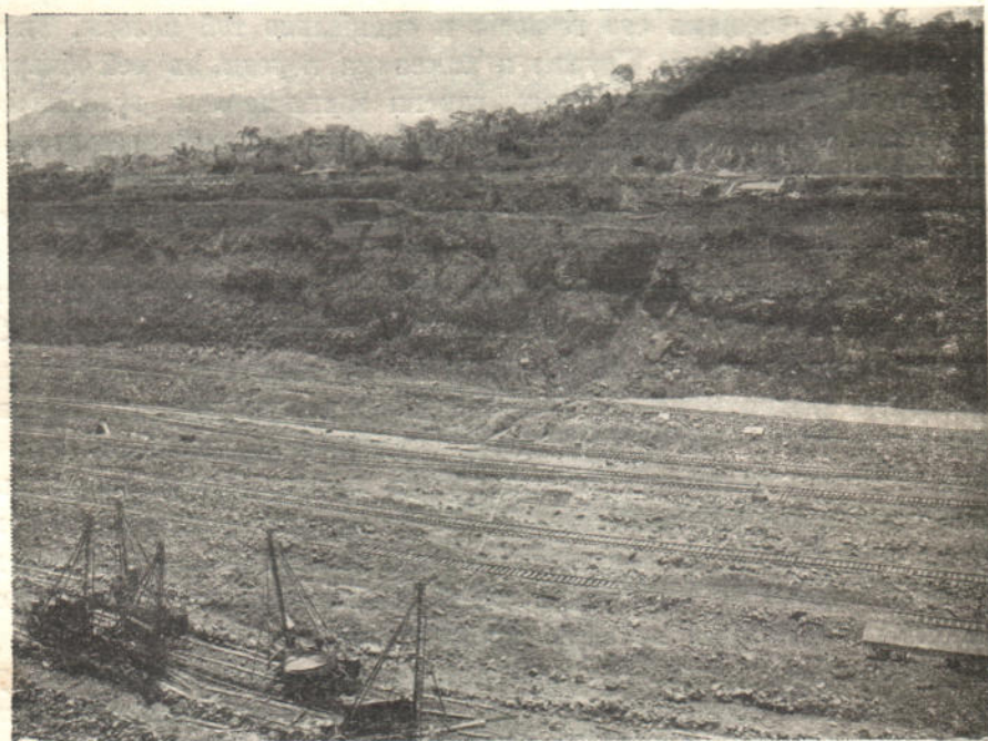
Рис. 47. Видь обвала, или оползня первой категоріи.
