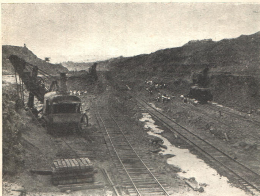
Рис. 6. Расположеніе паровыхъ лопатъ при разработкѣ слоя перевальной выемки.
