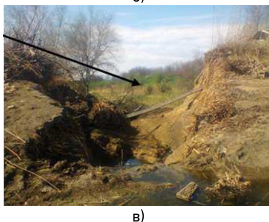
Рис. 3. Руйнування середньої дамби (а) каскаду водойм (поз. 2 на рис. 1); ложе спустошеного ставка (б); формування прорану та обвал ґрунтових мас (в) зі сторони верхнього б'єфу (висота дамби близько 6 м)
