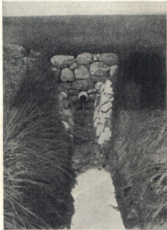
Устье изъ цементной трубы, защищенное камнемъ.
