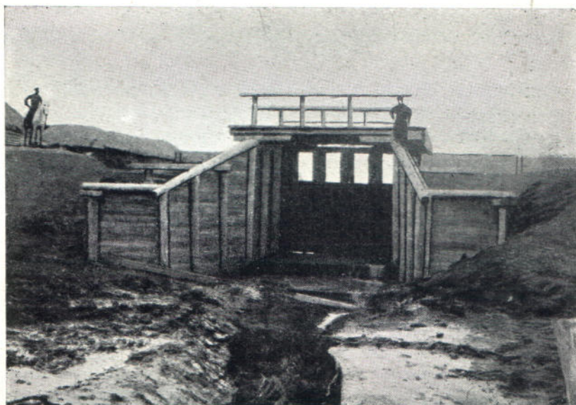
Деревянный водоспускъ съ низовой стороны.
