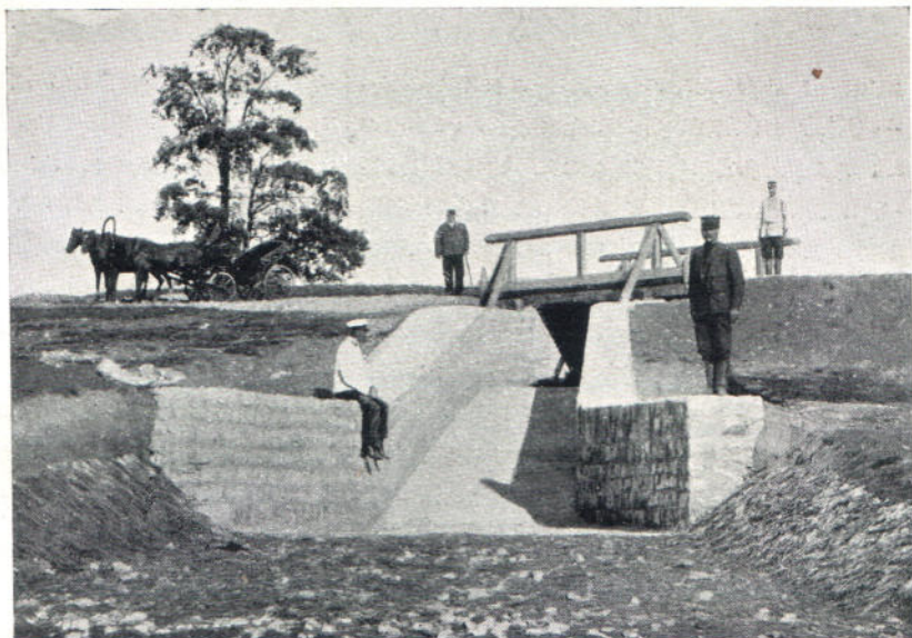
Каменно-бетонный наклонный водоспускъ.
