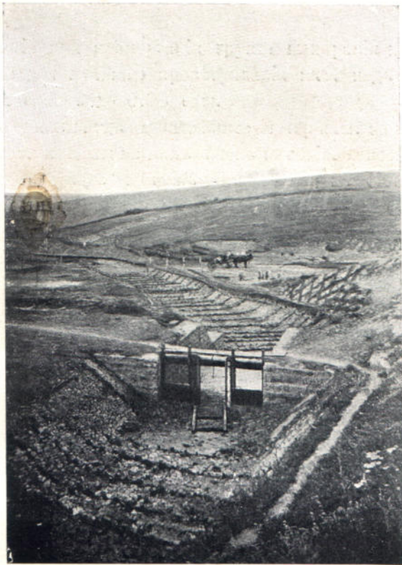
Водосливная канава, укрѣпленная плетнемъ и мощеніемъ.
