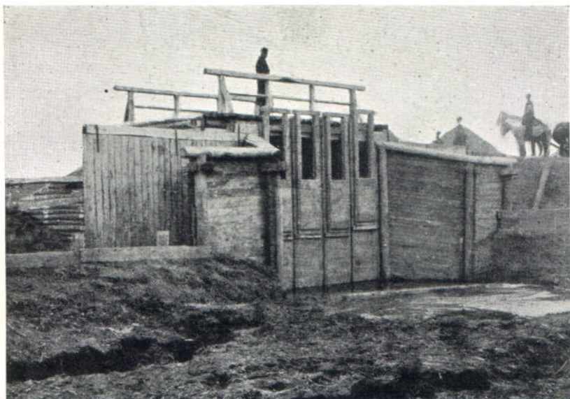
Деревянный водоспускъ со стороны воды.
