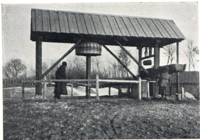
Глубокій колодець съ коннымъ приводомъ.
