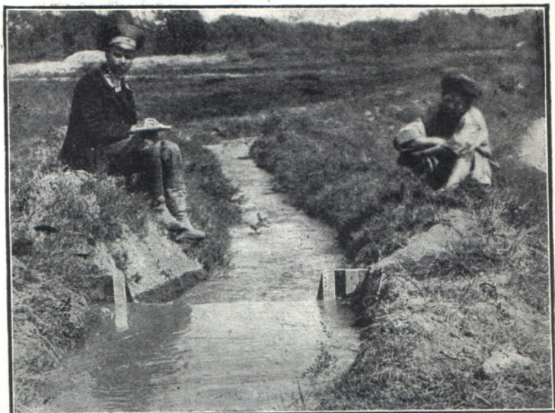
Учет воды водосливомъ Чиполоетти (съ напорной стороны). (Самаркандская обл., Зеравшанская дол.).
