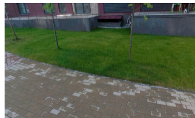
Рис. 3. Правильна конструкція тротуару (ЖК «Spectrum», вул. Костромська, м. Рівне) Фото автора, 2019 р.
