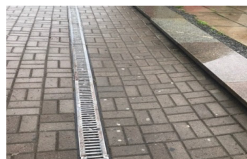
Рис. 6. Організація водовідведення з тротуару або проїжджої частини (пл. ім. В. Короленка, м. Рівне). Фото автора, 2019 р.
