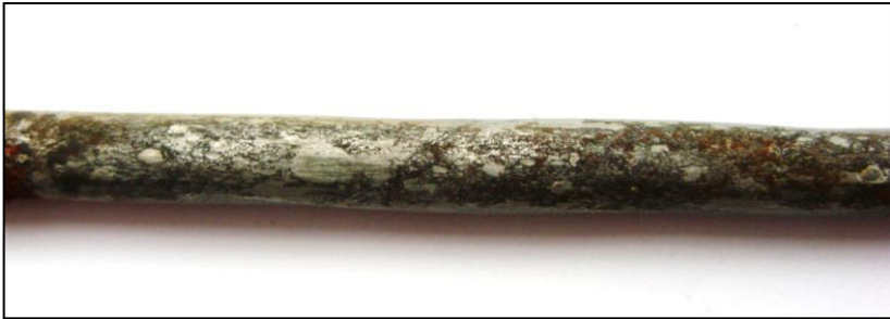
Рис. 2.12. Корозія арматури в зразках сульфатно-шлакового в'язучого (фосфогіпс – 5%), без добавок, що зберігались у воді
