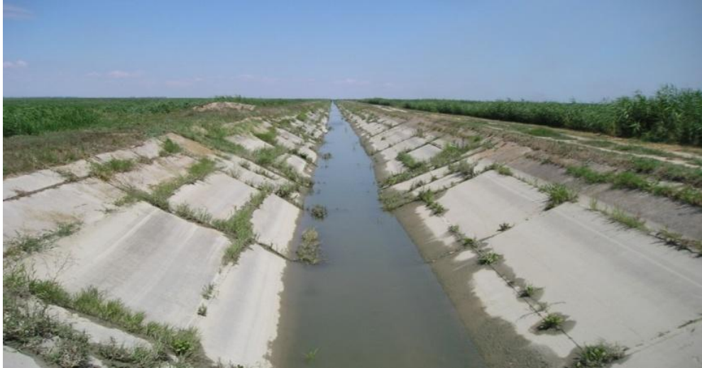
Рис. 2.9. Загальний вид ділянки каналу Р-2 КРЗС (після реконструкції у 1979 р.)
