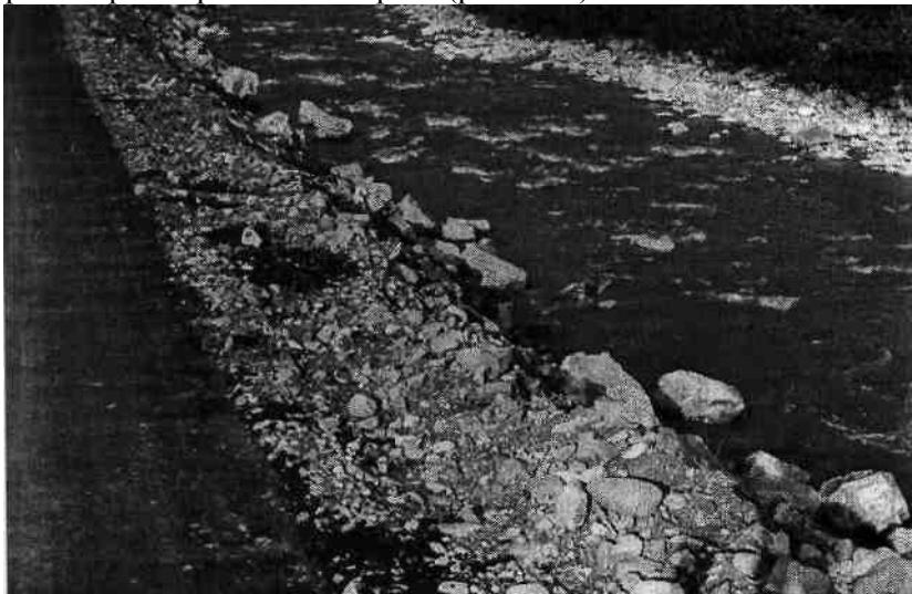
Рис. 2.37. Банкет з кам'яного накиду вздовж автомобільної дороги Івано-Франківськ—Бистриця (р. Бистриця Надвірнянська)
