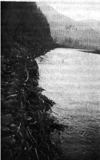
Рис. 2.36. Підпірна стіна з габіонів уздовж автомобільної дороги Куті-В. Ясенів (р. Черемош)
