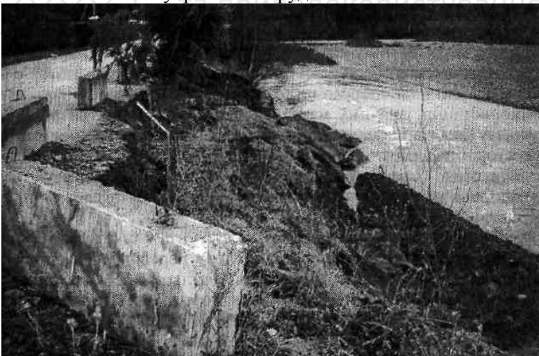
Рис. 2.41. Залишки зруйнованої повінню бетонної стіни
