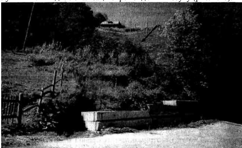
Рис. 2.46. Зсув верхового схилу на автомобільній дорозі Снятин–Кремінці (Українські Карпати). У підніжжя схилу влаштована підпірна стіна з залізобетонних блоків. Стрілкою показано місце розташування кабелю
