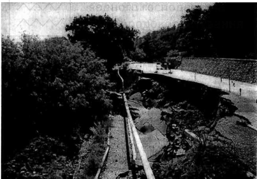
Рис. 2.43. Руйнування дорожнього покриття зсувом (Крим).
