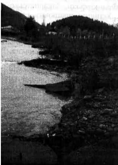
Рис. 2.35. Укріплення укосу земляного полотна напівзагатами з бра-кованих залізобетонних виробів (р. Черемош, 1982 р.)
