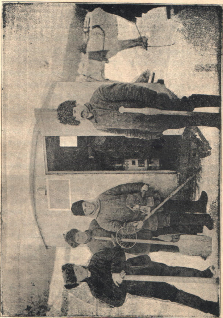
Подвижная будка для зимних гидрометрических работ.
