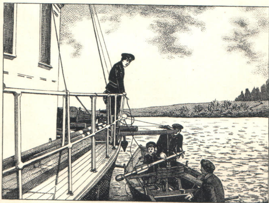
Опускание вертушки Отт'а съ парохода.
