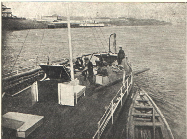
Весеннее опредѣленіе расходовъ воды непосредственно съ парохода.
