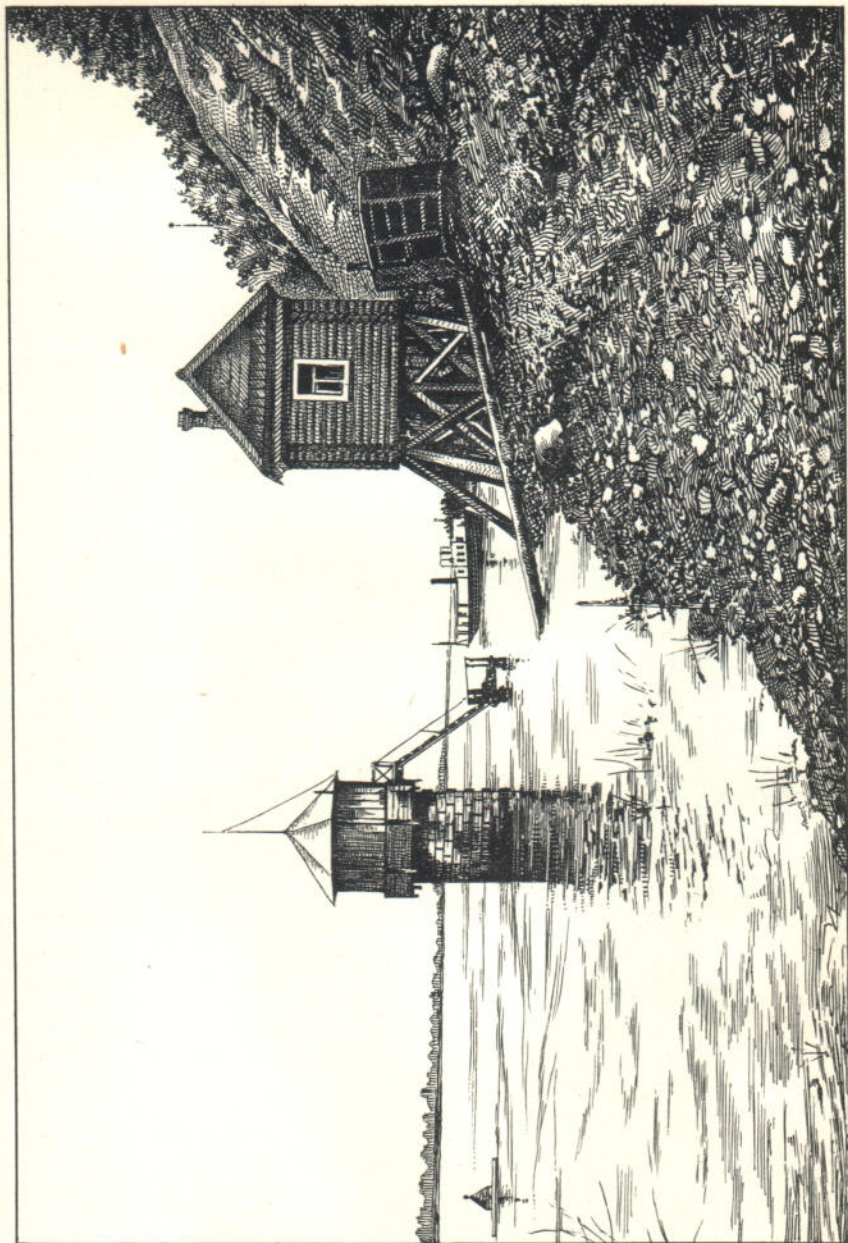
Будка Вязовской автоматической водомёрной рейки, въ высокую воду.
