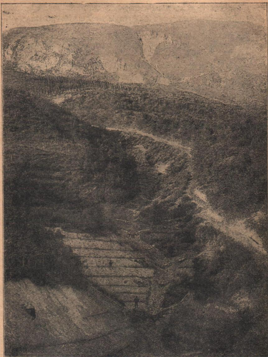
Рис. 40. каменный жолобъ и каменные поперечныя запруды. Въ вершинѣ оврага уже закончены облѣсительныя работы, тогда какъ ниже идутъ еще только подготовительныя къ тому работы.
