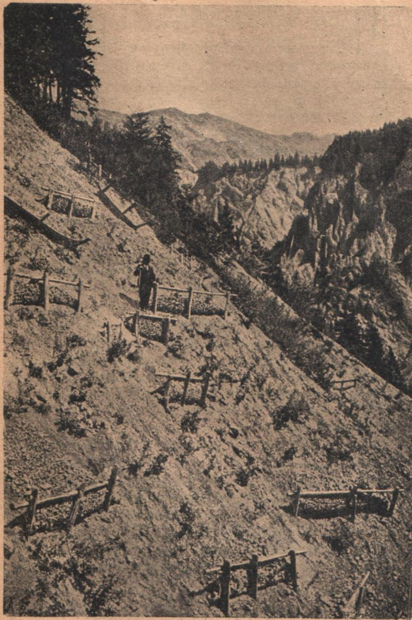
Рис. 48. Общий видъ распределения проволочныхъ загражденій по скату.
