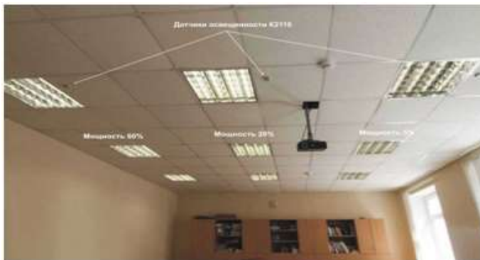
Рисунок 2.3. Розміщення світильників ЛПО 4 х(18 ÷80Вт)
