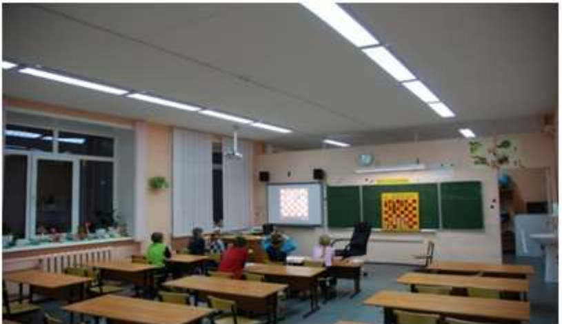
Рисунок 2.1. Освітлення приміщення люмінесцентними лампами
