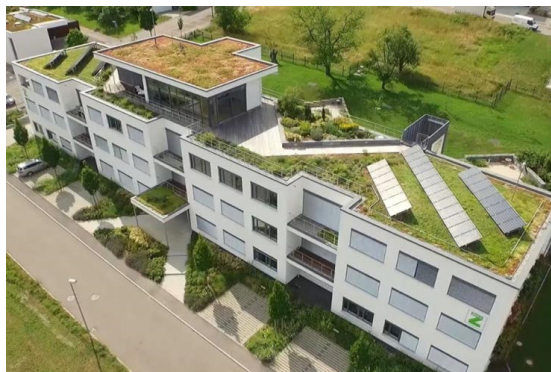
Рис. 4. Приклад дахового озеленення
