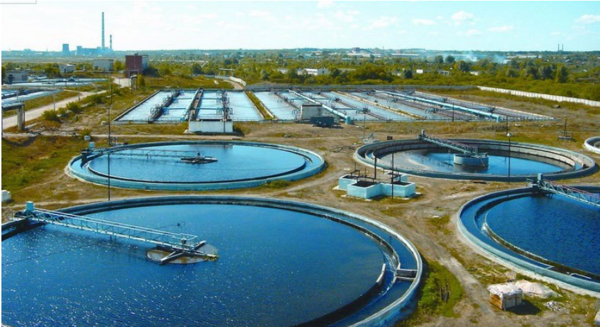
Рис. 1.2. Система біологічного очищення технологічних вод ( https://ziko.com.ua/all-article-ochysni-sporudy-stichnykh-vod/ )
