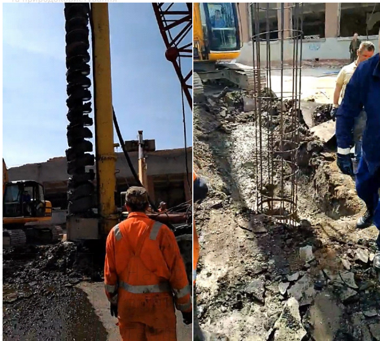
Рис. 5.4. Виготовлення буро-залівних паль у виробничих умовах ТОВ «Семікс бетон»
