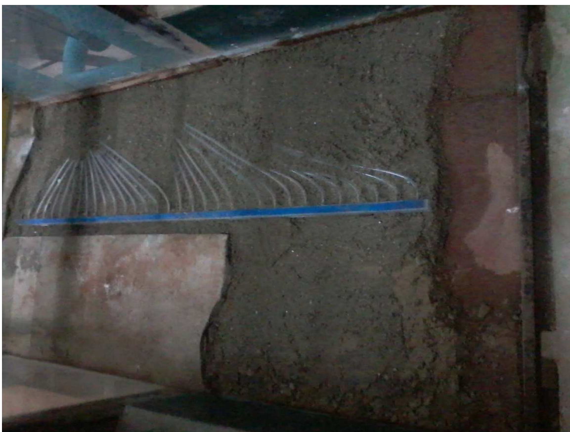
Рисунок 2.6 – Підготовка місця встановлення планки з приймальними отворами п'єзометрів до бетонування
