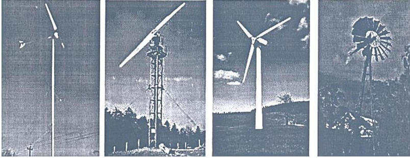
Рис. 4.2 – ВЕУ з горизонтальною віссю обертання: а) однолопатева; б) дволопатева; в) трилопатева; г) багатолопатева
