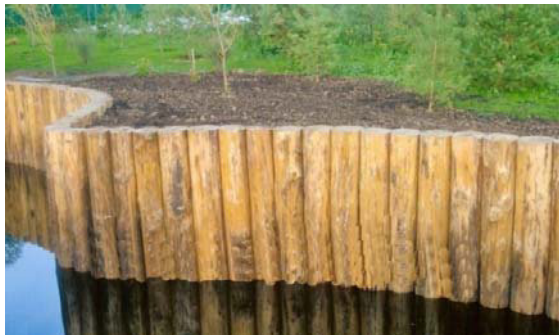
Рис. 3. Кріплення берегів водойми за допомогою дерев'яних паль
