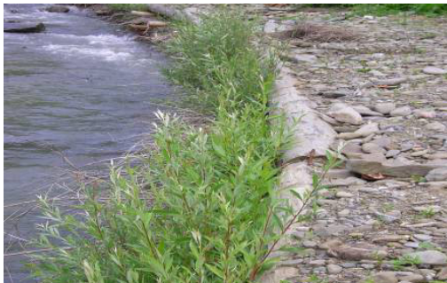
Рис. 5. Біологічне кріплення
