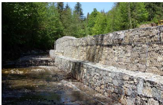
Рис. 2. Габіонне кріплення річки
