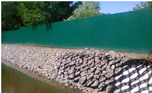
Рис. 4. Заповнення георешітки кам'яним накидом
