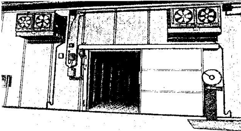
Рис. 2.10. Камера холодильника, яка охолоджується вмонтованими у зовнішню стіну блочними холодильними машинами
