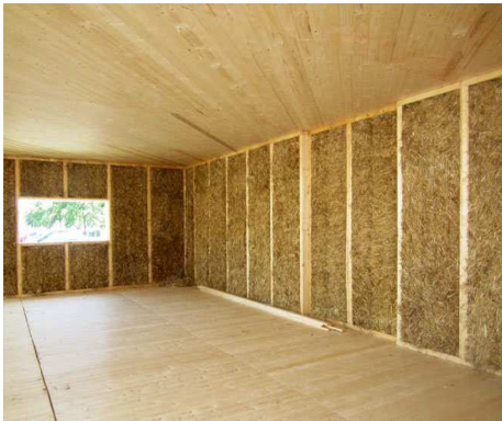
Рисунок. Каркасне будівництво із солом'яними панелями
