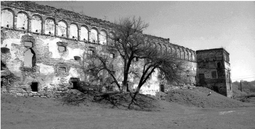
Рис. 32. Старе Село. Загальний вигляд замку Острозьких з північного сходу. Фото автора. 2001р.
