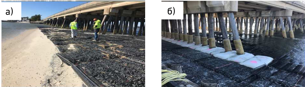
Рис. 6. Кріплення опор мостів з використанням матраців ТРИТОН®: а – загальний вигляд; б – фрагмент кріплення дна
