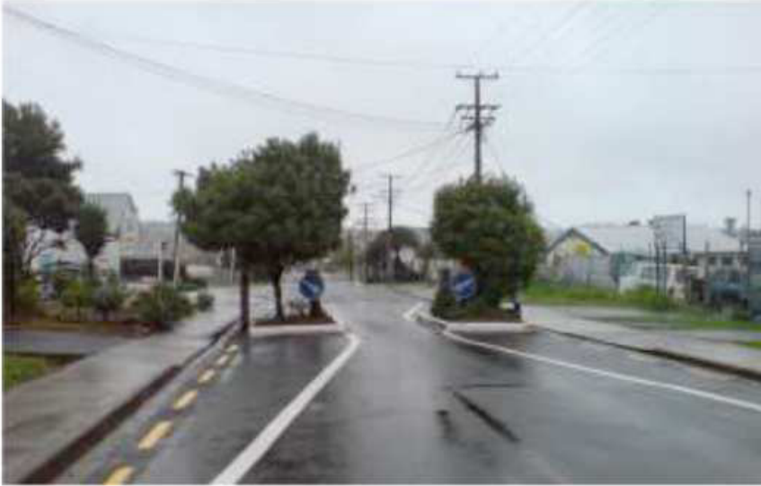
Рис. 4. Приклад влаштування чокера [2]
