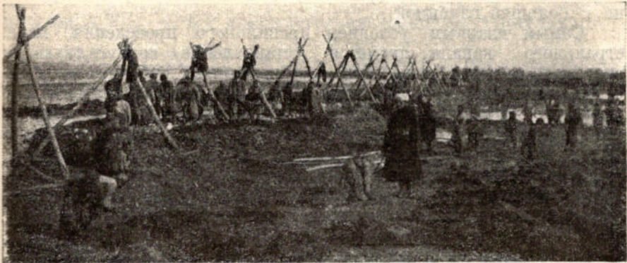
Фиг. 11. Сипайное головное сооружение в Средней Азии.
