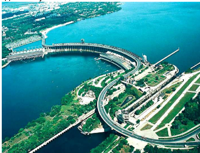
Рис. 1. Автодорожній перехід по спорудах греблі ДніпроГЕС
